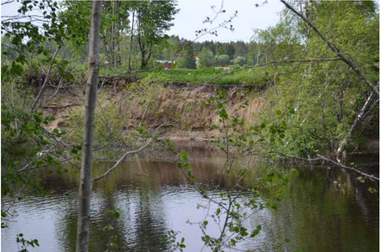
Joen syövyttämää eroosiorantaa. Kuva: Virpi Karén
