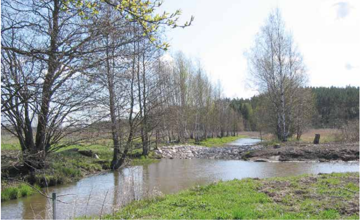
Krapuojan kosteikkoalueeseen kuuluvat varsinaisen kosteikon lisäksi ylemmäksi uomaan tehdyt pohjapadot pienine levennyksineen. Kuva: Anni Karhunen
