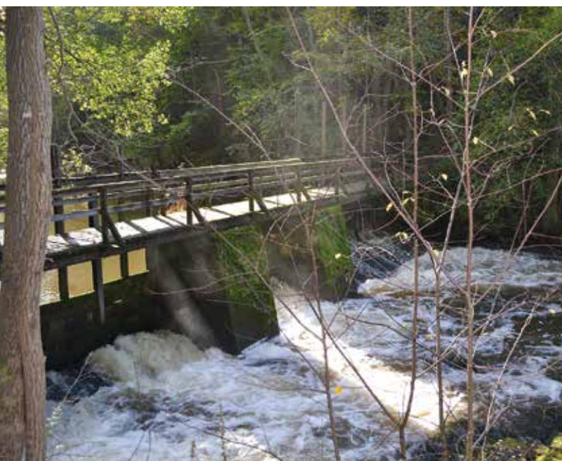
Latokartanonkosken yläpuolella sijaitseva Hamarinkosken säännöstelypato luonnonmukaistettiin pohjapadoksi vuoden 2012 aikana. Padon muutostyön jälkeen Latokartanonkoskeen rakennettiin uusi koskenniska. Kuvat: Marjo Perkonaja
