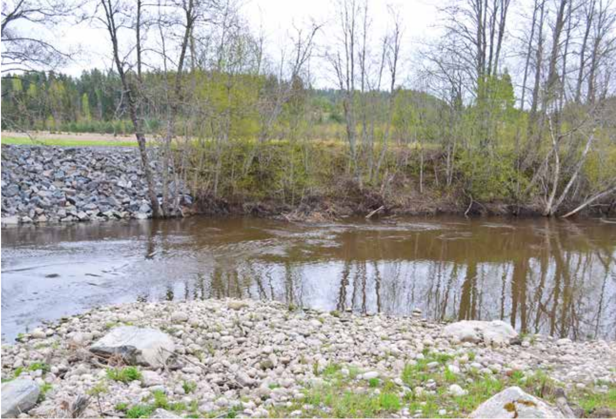
Jotta Saarenjärven tulvat eivät nousisi Hamarinkosken ja Saarenjärven pohjapatojen rakentamisen myötä, kunnostettiin jokiosuudella Prinkkalan kaksi virtapaikkaa. Kuva: Marjo Perkonoja
