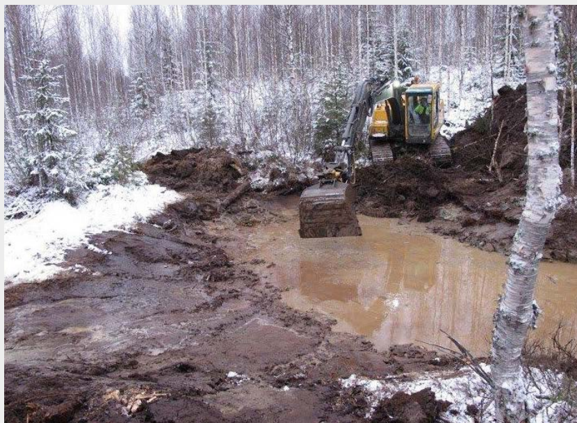
Kuva 36. Uuden rupiliskolammen kaivutyöt käynnissä. Kuva: Ville Vuorio
