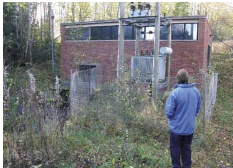
Arrakosken pienvoimalaitoksen turpiinin teho on 530 kW ja keskimääräinen energiantuotanto 1 500 MWh vuodessa. Vesi voimalaan johdetaan maanalaisella putkella yläpuolisesta Miestämä-järvestä ohi vanhan uoman.
