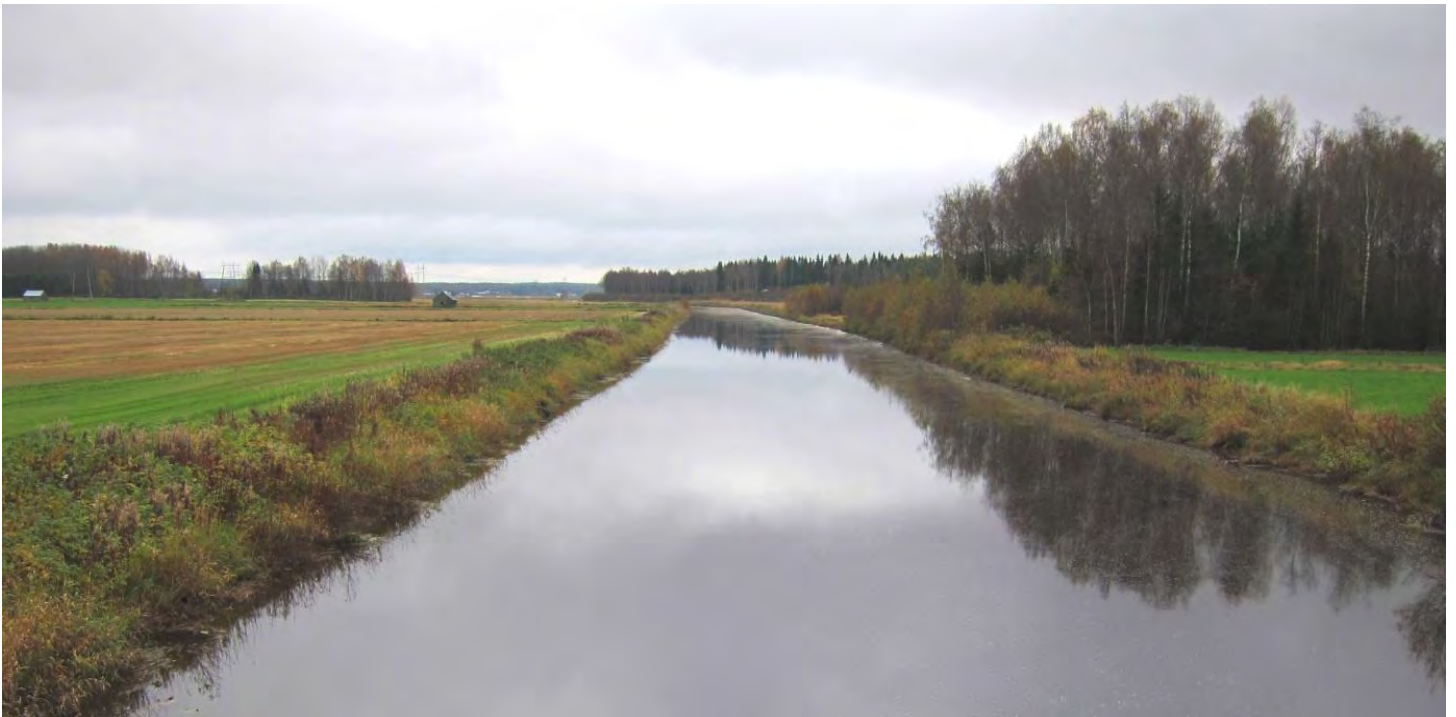
Vörå å på södra sidan av riksåttan.
