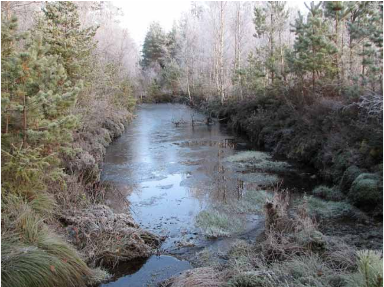
Tyypillinen laskeutusallas. Se toimii parhaiten siellä, missä maa-aines laskeutuu nopeasti ja on siksi usein käytössä metsäojitusten vesiensuojelussa. Kuva: Anni Karhunen
