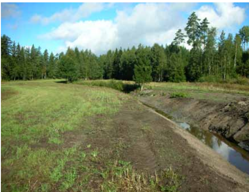
Perattu oja. Tässäkin tapauksessa alivesiuoma, tulvatasanteet ja reunojen loivennus olisivat voineet olla luonnonmukaisempi ratkaisu. Kuva: Ritva Kempainen
