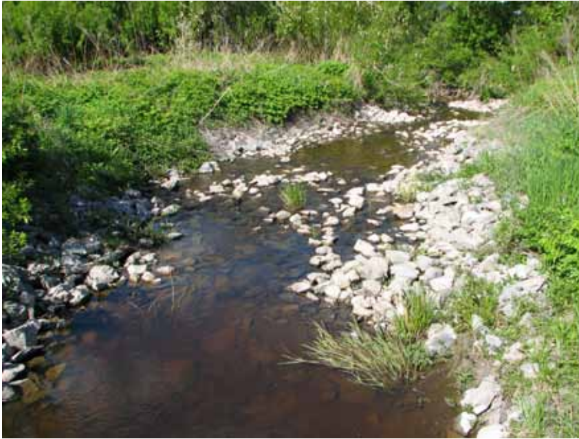
Kaloille sopiva pitkä ja loiva pohjapato. Kuva: Anni Karhunen
