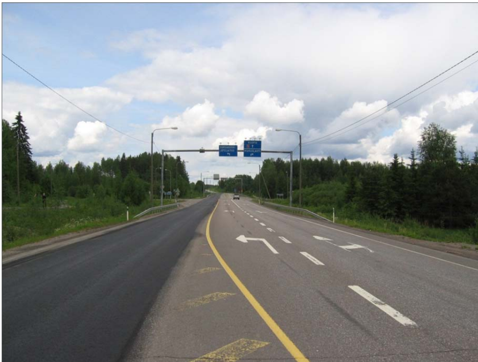
Kuva 5-9. Riikinnevan jätekeskukseen valtatieltä 5 johtava Huruslahden nelihaaraliittymä on hankala varsinkin sivusuunnasta ruuhka-aikaan päätielle pyrkiville.
