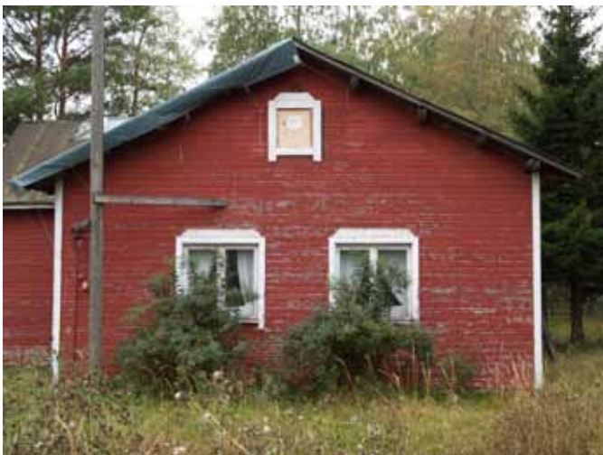
Julkisivu pihan puolelta, takaseinä ja pohjoispäätty.
