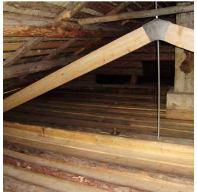
Ullakolla oleva yläpohjarakenteita jäykistävä nk. ansarakenne.
