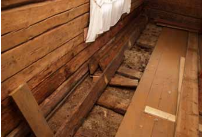
Tuvan vanha lattia avattuna.
