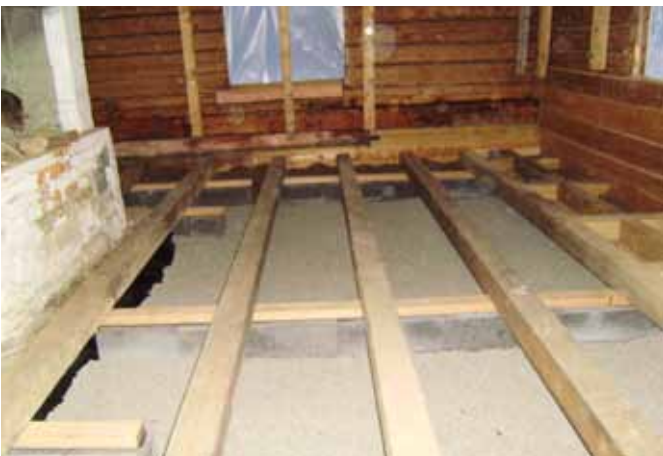
Lattianiskat (150x150) asennettuina. Niiden päälle naulattiin lattialaudat.
