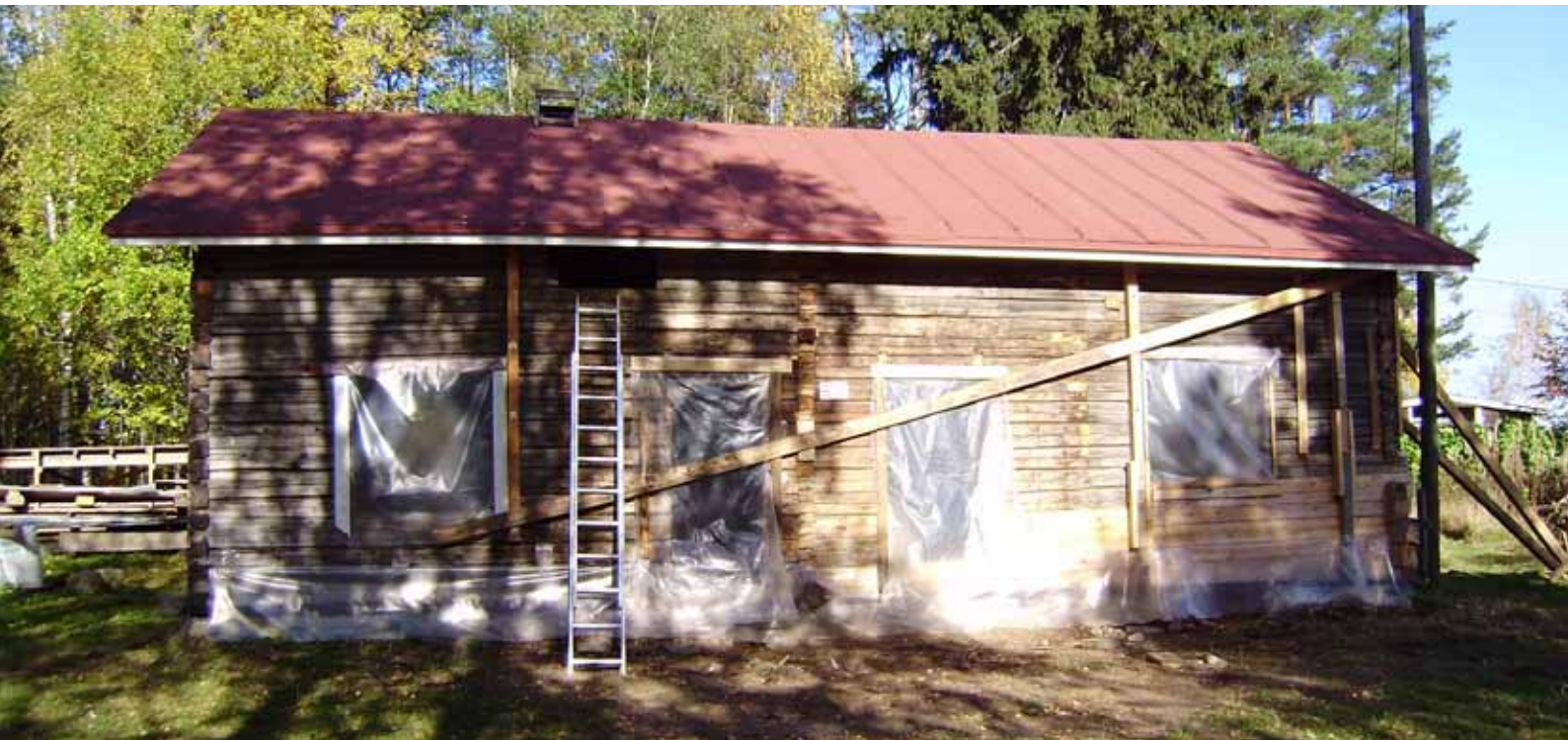
Uusi kolmiorimakiinnitteinen bitumikermikate.
