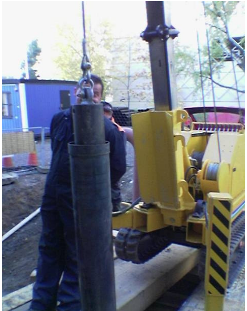
Kuva 7. Paalutuskoneen 500 kg pudotusjärkäle teräsputken sisällä. /15/
