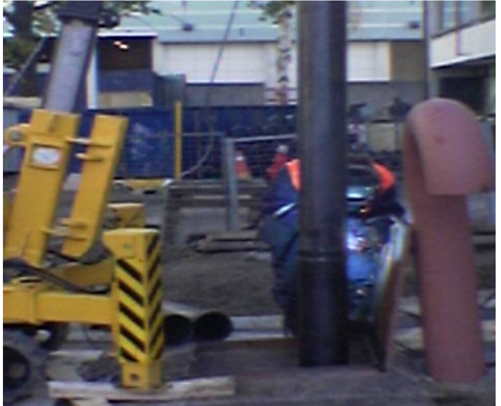
Kuva 14. Paalun jatkaminen hitsaamalla. /15./
