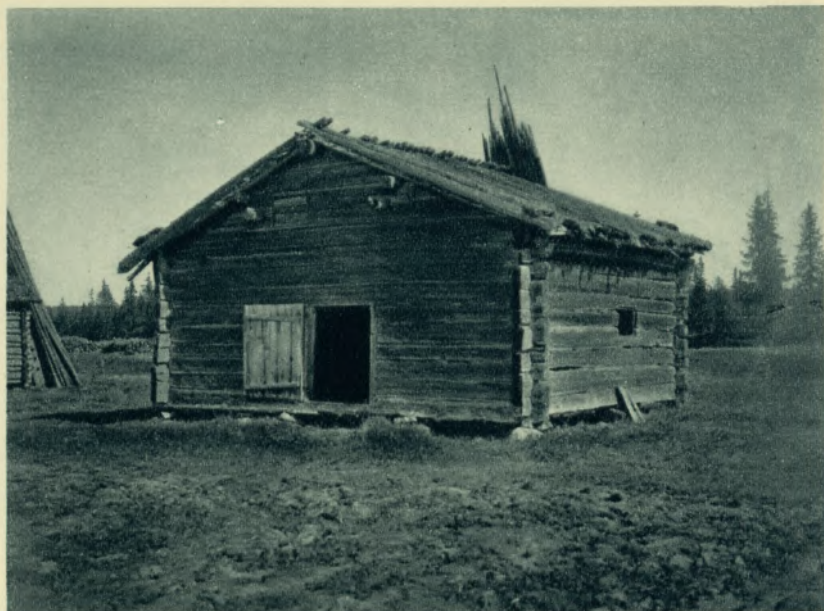
Jatkon lato, ollut ennen savupirttinä. Täräntö.
