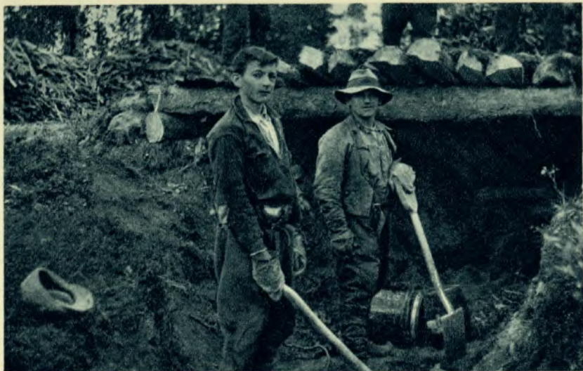
Junkkalaiset laittavat tervahaudan halssia. Sivulla silputtu tervasröykkiö.
