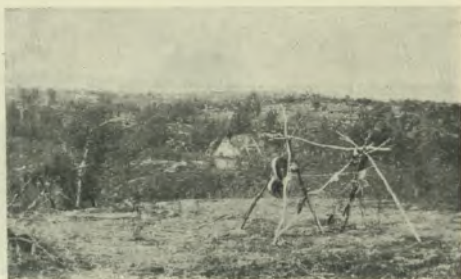
Kesäinen kotakenttä tunturilla. Etualalla suonjer, taempana kota.
