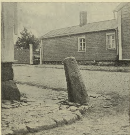
Kivipatsas Aita- ja Mentzerinkatujen kulmassa.
