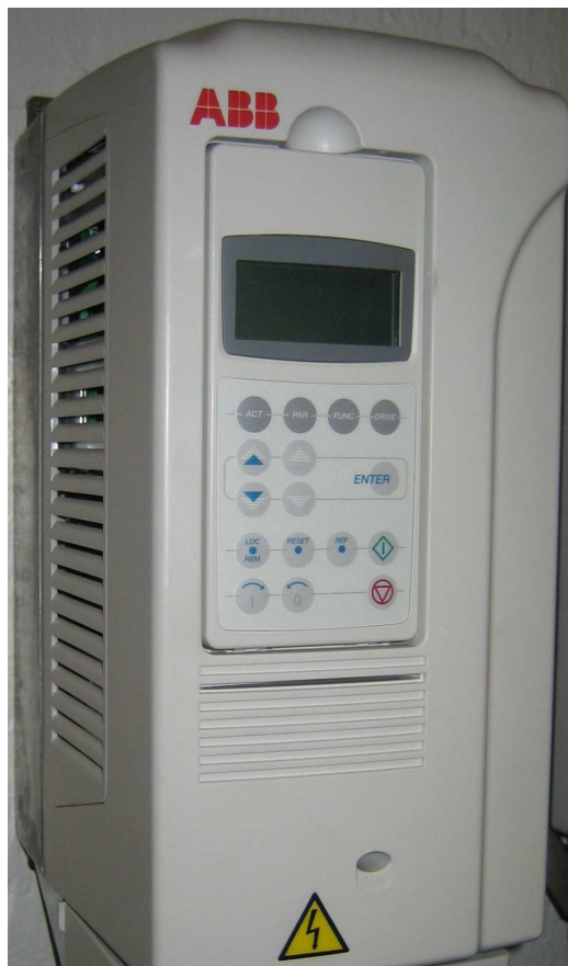
Kuva 3. ABB:n ACS800-sarjan R2-runkokoon ja IP21-suojaluokan taajuusmuuttaja seinään kiinnitettynä; keskellä näkyvän ohjauspaneelin kautta voidaan ohjata taajuusmuuttajan toimintaa
