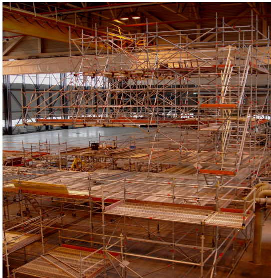
Kuva 9. Airbus 320 -lentokoneille rakennettu purettava pyrstöhuoltotasoa.
