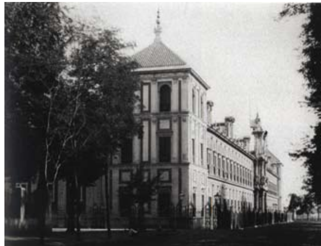
212. Ramón Almela, Palacio de San Telmo. Fachada principal , ca. 1900. Fototeca Municipal de Sevilla.
