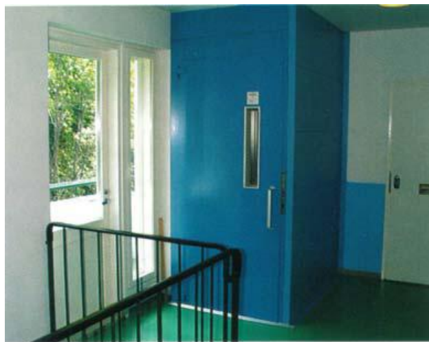
Kuva 11. Minihissi on sijoitettu porrastasanteen kohdalle yksivartisessa porrashuoneessa.
