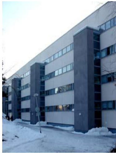
Kuva 8. Hissin sijoittaminen rakennusrungon ulkopuolelle muuttaa rakennuksen julkisivua.
