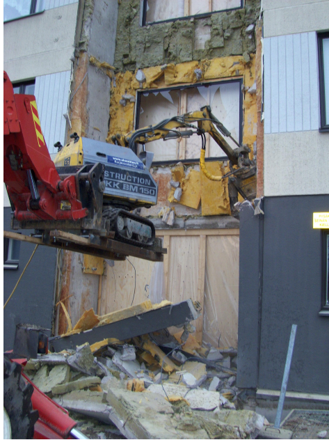
Kuva 18. Purkurobotit soveltuvat hyvin julkisivujen purkamiseen silloin, kun hissi tai uudet portaat rakennetaan rakennusrungon ulkopuolelle. tällaisissa purkutöissä syntyy runsaasti erilaista pölyä, jonka leviäminen rakennuksen sisälle ja ympäristöön tulee estää.
