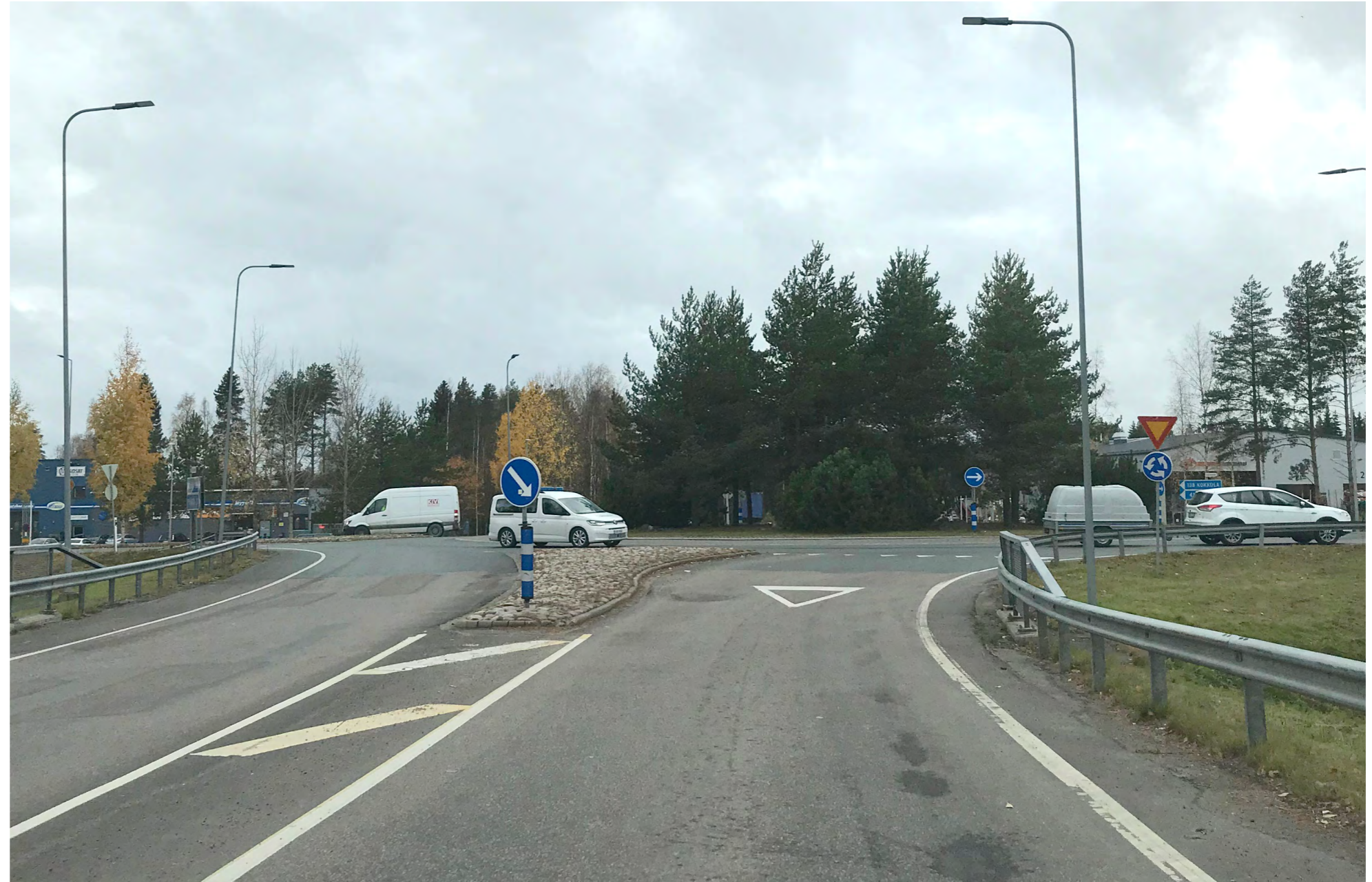
Kuva 4.3. Kärsämäen taajaman kohdalla nykyinen valtatie 4 kiertoliittymineen ja suojateineen jää paikallisen liikenteen käyttöön. Liikenne vähenee nykytilanteesta ja etenkin jalankulun ja pyöräilyn turvallisuus paranevat.
