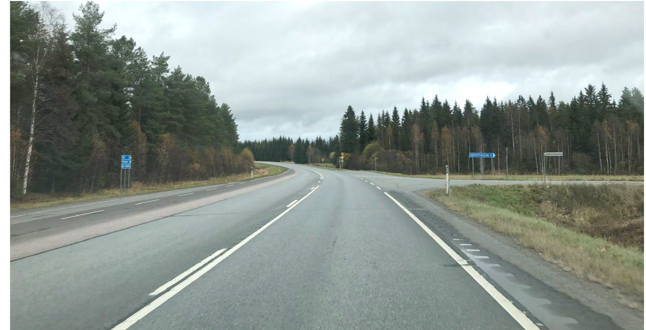
Kuva 3.5. Oravankylän kohdalla valtatie 4 siirretään uudelle tielinjalle ja nykyinen valtatie 4 (kuvassa) jää paikallisen liikenteen käyttöön.
