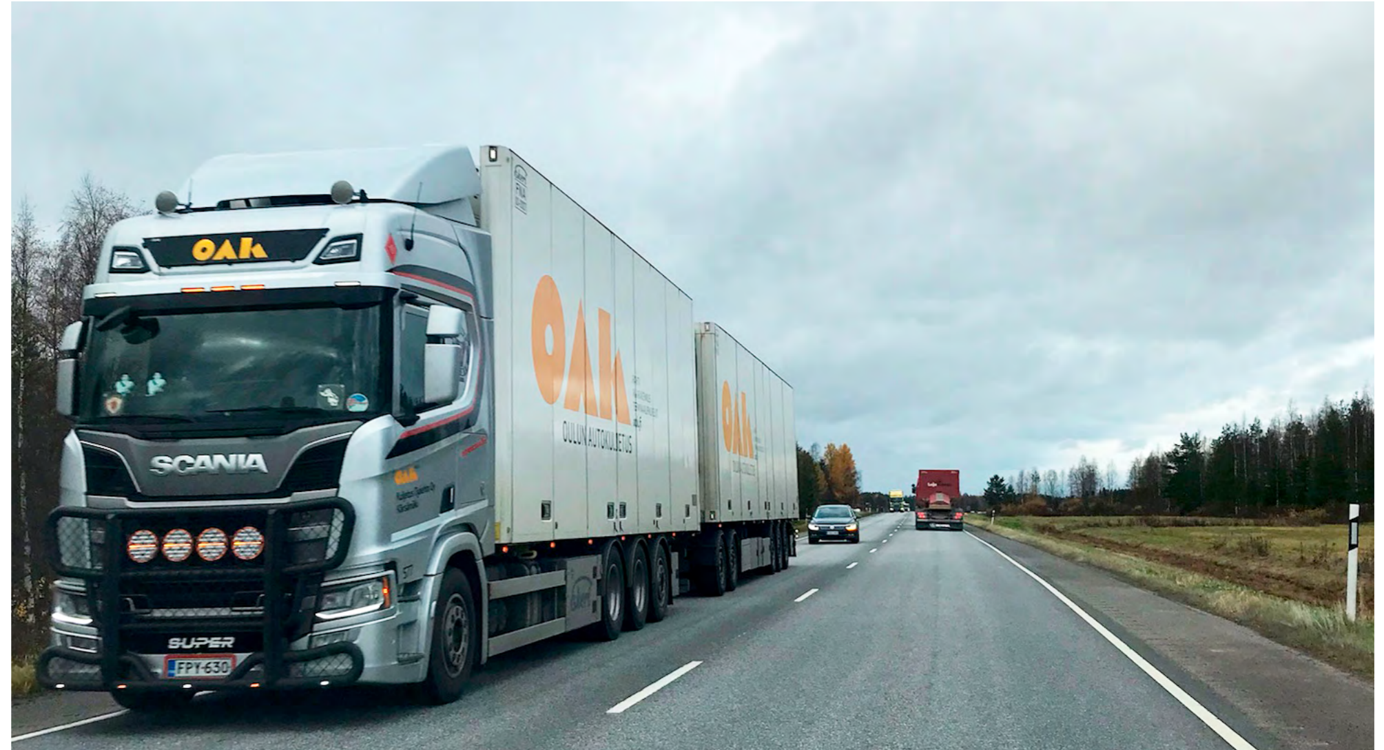
Kuva 4.1. Valtatie 4 sujuvuus ja turvallisuus paranevat, kun tiejaksolla on säännöllisesti ohituskaistoja, jotka mahdollistavat turvalliset ohitukset.
