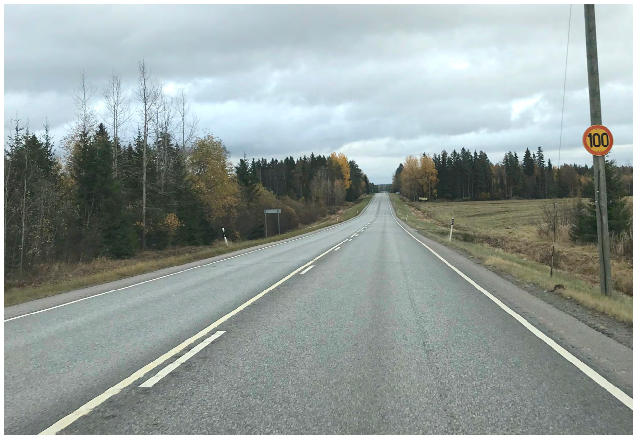
Kuva 4.2. Valtatien 4 nopeusrajoitus on tavoitetilanteessa pääosin 100 km/h. Pyhäjärvi-Pulkila-jaksolle jää kaksikaistaisia osuuksia, joilla ei ole keskikaidetta. Valtatien 4 geometria ja liikennemäärät mahdollistavat ohittamisen myös näillä ohituskaistojen välisillä jaksoilla.
