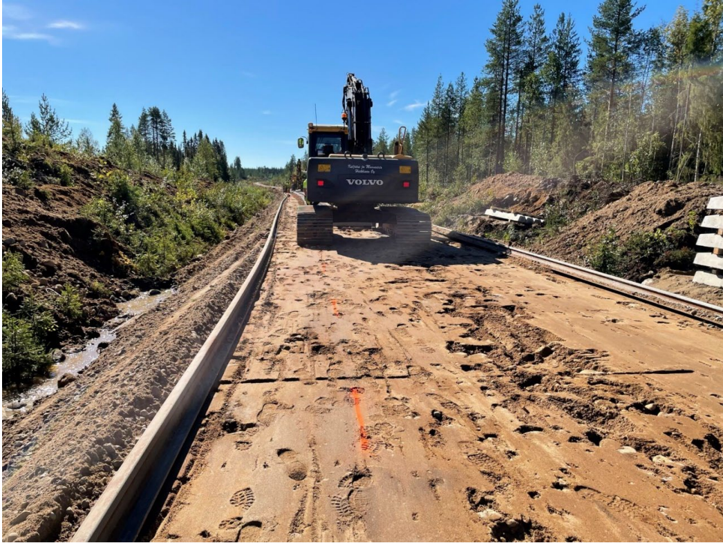
Kuva 18. Routalevyn asennusalusta soramateriaalissa. Kuva: Henri Seppälä.
