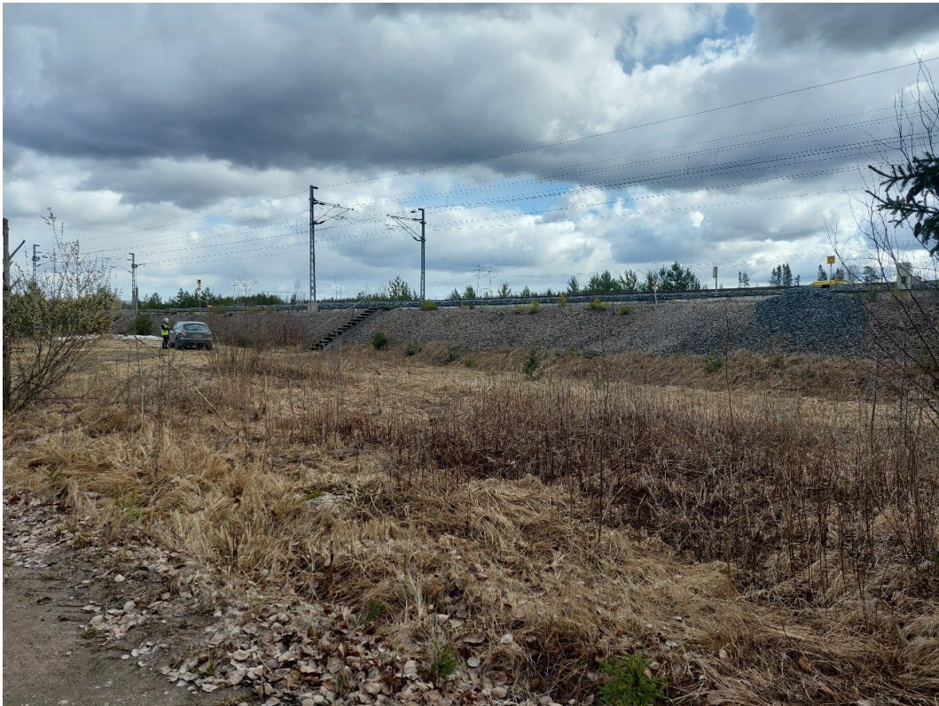
Kuva 117. Hennan nousupaikkatoive km 80+265 sijaitsee penkereen päällä (Kuva: Martta Viljanen, 29.4.2022).
