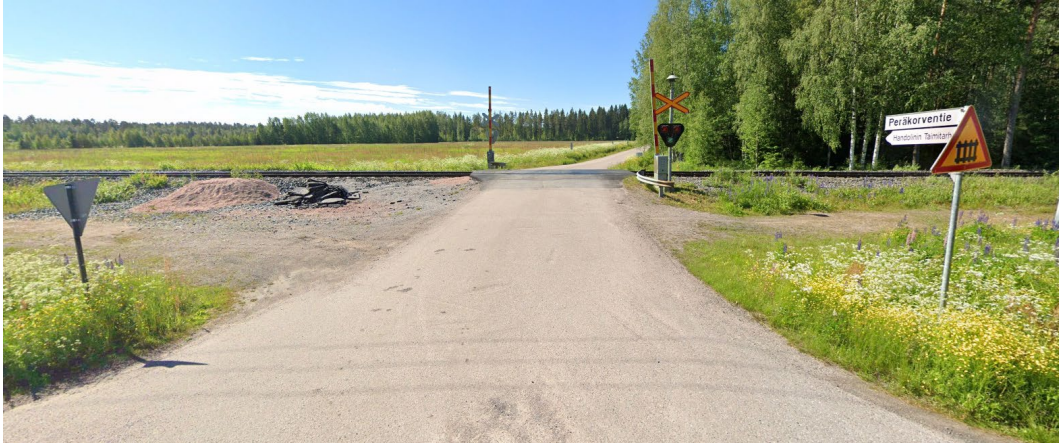
Kuva 137. Korventie–Peräkorventie-liittymä kesäkuu 2021 (Kuva: GoogleMaps StreetView 24.1.2023).
