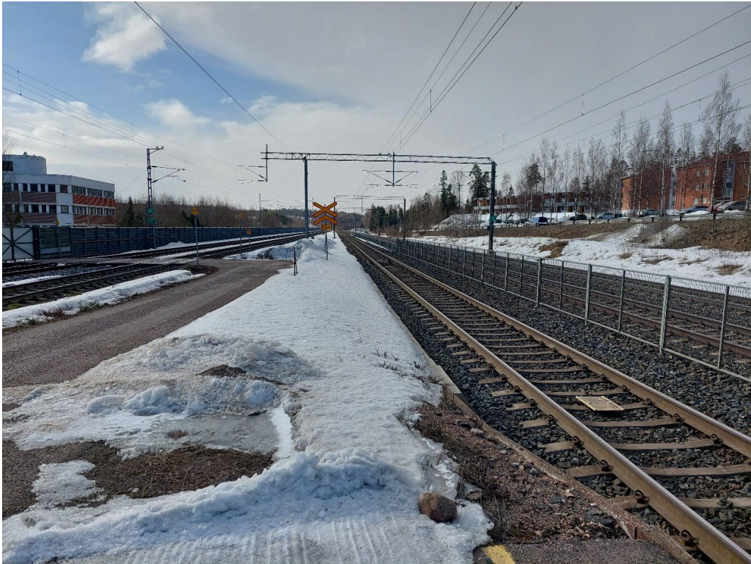
Kuva 114. Savion Vuosaaren raiteen ja itäisen raiteen nousupaikka sekä uusi nousupaikka toivottu viereen itäiselle keskiraiteelle (Kuva: Martta Viljanen, 30.3.2022).
