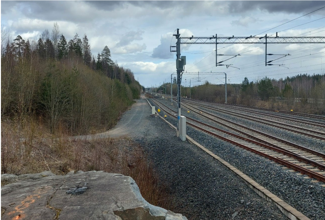
Kuva 116. Mäntsälän huoltoraide R405 sekä vieressä kulkeva tieyhteys ja kaapelikouru (Kuva: Martta Viljanen, 29.4.2022).
