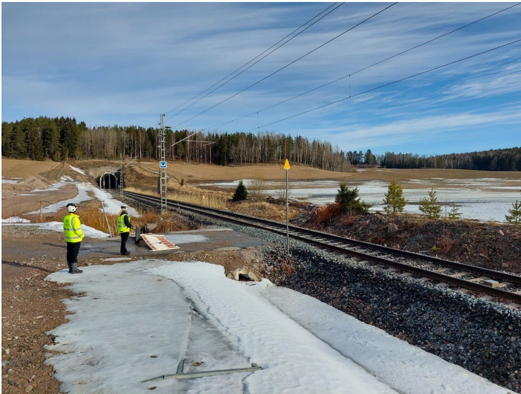
Kuva 122. Perniön sähkönsyöttöaseman poistettu nousupaikka (Kuva: Martta Viljanen, 13.4.2022).
