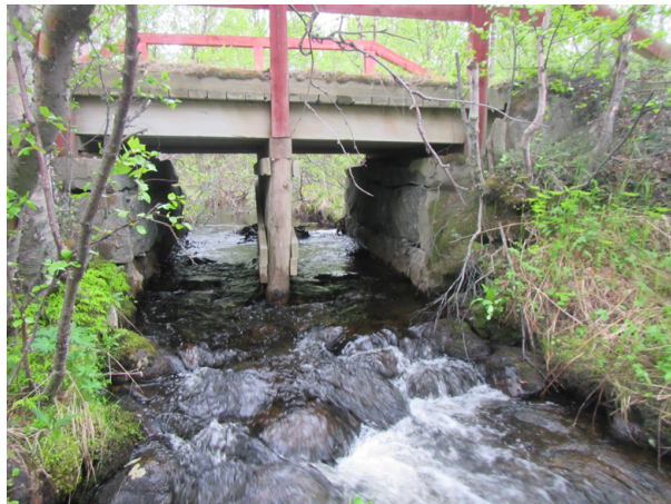
Kuva 54., Kunnostettavan puukantisen sillan kohdalla virtaa vuolas puro kesäkuussa 2022.
