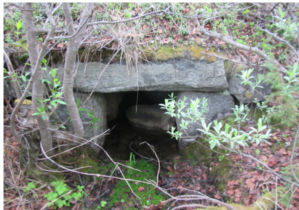
Kuva 62., Puuvartisista kasveista ja heinästä puhdistettavia kivirumpuja.
