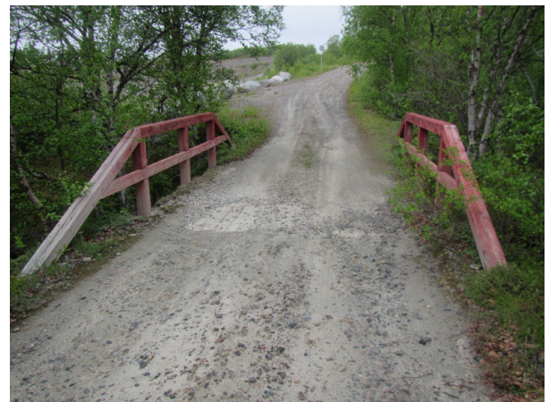
Kuva 32., Nykyinen silta, jonka puinen kansi on kulunut ja kai- teiden väri haalistunut.
