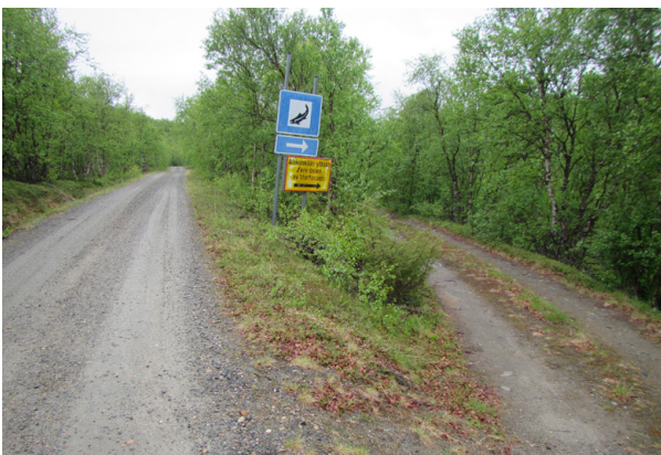
Kuva 35., Vanhan tielinjan liittymä jokirantaan.
