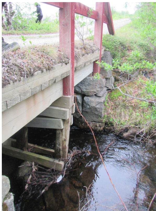
Kuva 63., Sillan rakenteet esitetään tarkastettavaksi. Sillan ympäristöstä raivataan puuvartist kasvit ja heinikko.
