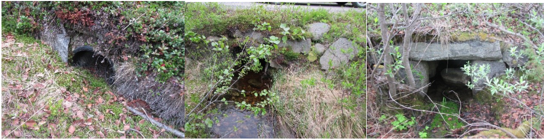
Kuvat 7,8 ja 9: Museotien nykyisiä muovi- ja kivrumpuja.
