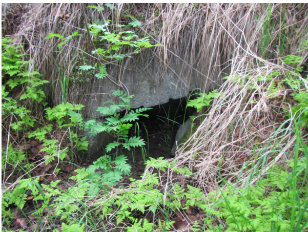
Kuva 61., Puuvartisista kasveista ja heinästä puhdistettavia kivirumpuja.
