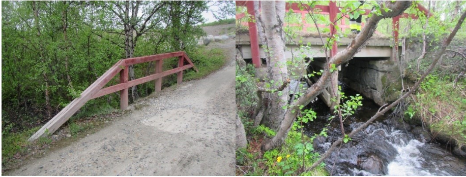
Kuvat 5 ja 6: Nykyinen puukantinen silta, jonka painorajoitus on 4 tonnia.
