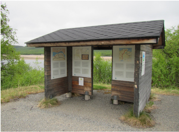
Kuva 23., Puurakenteinen opastuskatos on hyväkuntoinen.
