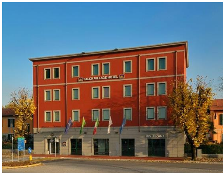
Bild 15 Falck Village Hotel. https://www.falckvillagehotel.it/en/photogallery.aspx Best Western Falck Village Hotel, Sesto San Giovanni. Hämtad från deras webbplats 21.10.2022
