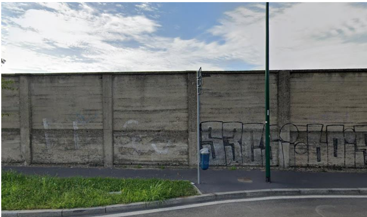
Bild 11 Via Trento. Google street view av 2 Via Trento, från augusti 2020. Hämtad 02.11.2022
