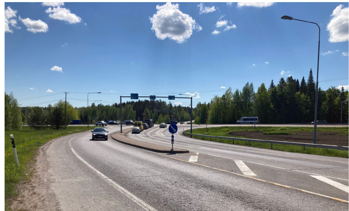
Kuva 2.5. Maantien 140 liittymä on kanavoitu liikennevaloin ohjattu tasoliittymä.
