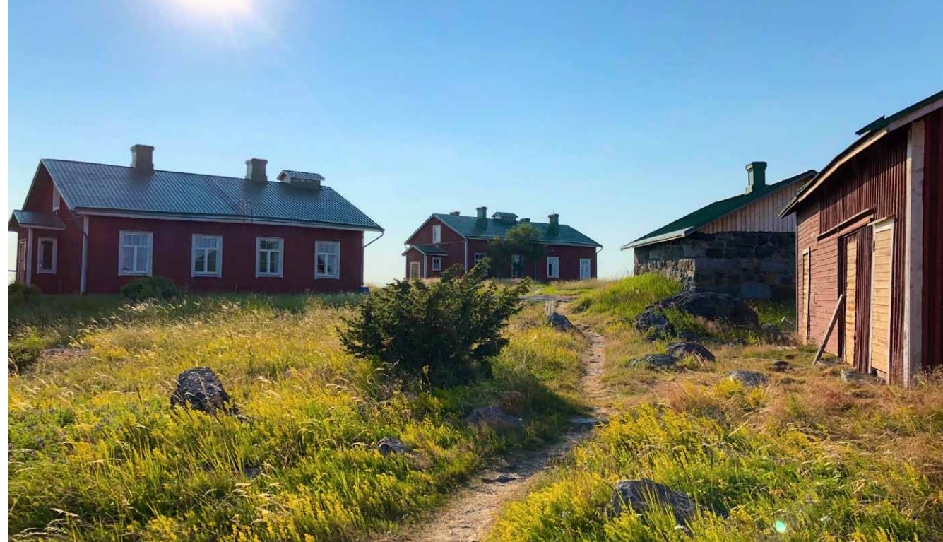
Rönnskärs vedlidor närmast kameran, sen följer källaren av sten. Nedre lotsstugan uppfördes 1924. Högst upp finns övre lotsstugan som byggdes 1899. Vedlidret och källaren borde också ha byggare 1899. Foto: Christian Höglund
