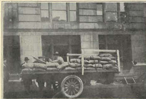
Liikkuva katusulku laitettu valmiiksi lakkolaisia varten.
