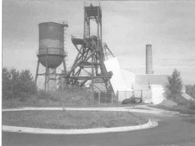
Vierailijoillekin avoin Elyn viimeinen kaivos on suomalaisille tuttu työpaikka. – The last mine in Ely, also open for visitors. Many Finns worked here.
