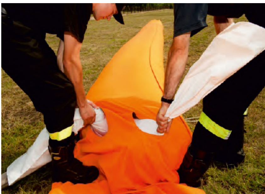
Kuva 8. Tulvasuojausesimerkkejä: a) tulvapenger, jota tarvittaessa korotetaan lankuilla (Jalasjärvi), b) pelastuslaitoksen tilapäinen tulvaseinä, ns. tulvapatki, Laihian- ja Kyrönjoen välisellä bifurkaatioalueella (Vaasa).
