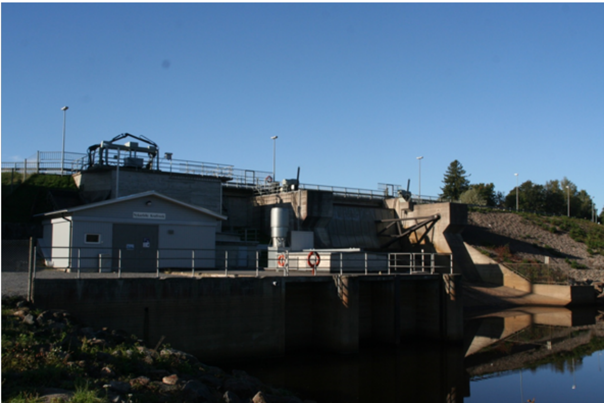
Kuva 12. Stadsforsin pato Uudessakaarlepyyssä. (Katja Haukilehto 2010)
