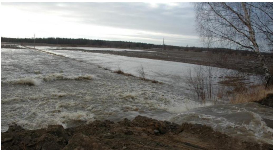
Kuva 21. Lapväärtinjoen alaosalla avattiin penger tulvavahinkojen vähentämiseksi keväällä 2013 (Kim Klemola)
