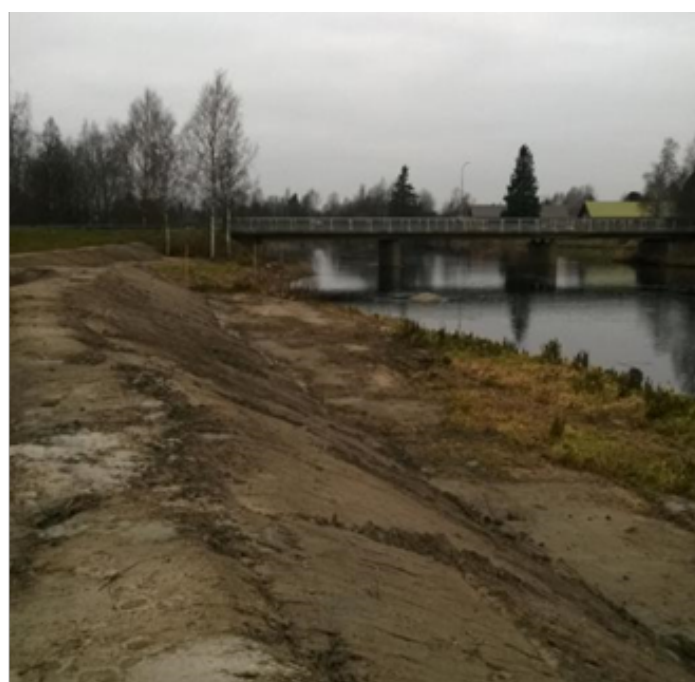
Kuvat 7 ja 8. Esimerkkejä ensimmäisen vaiheen aikana Lapväärttiin rakennetuista tulvapenkereistä ja -seinistä Holmforsin (vas.) ja Uudensillan (oik.) kohdilta. (Liisa Maria Rautio)
