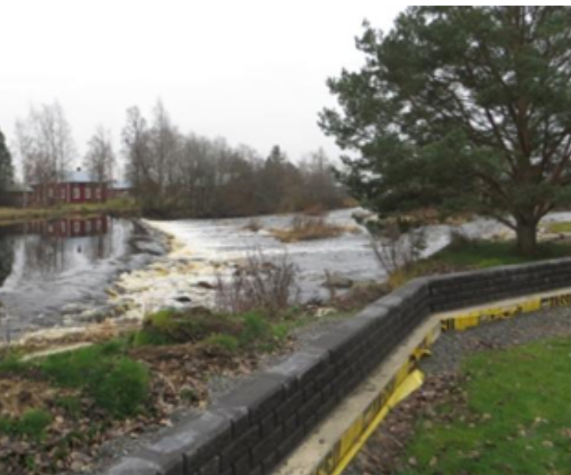
Kuvat 7 ja 8. Esimerkkejä ensimmäisen vaiheen aikana Lapväärttiin rakennetuista tulvapenkereistä ja -seinistä Holmforsin (vas.) ja Uudensillan (oik.) kohdilta. (Liisa Maria Rautio)
