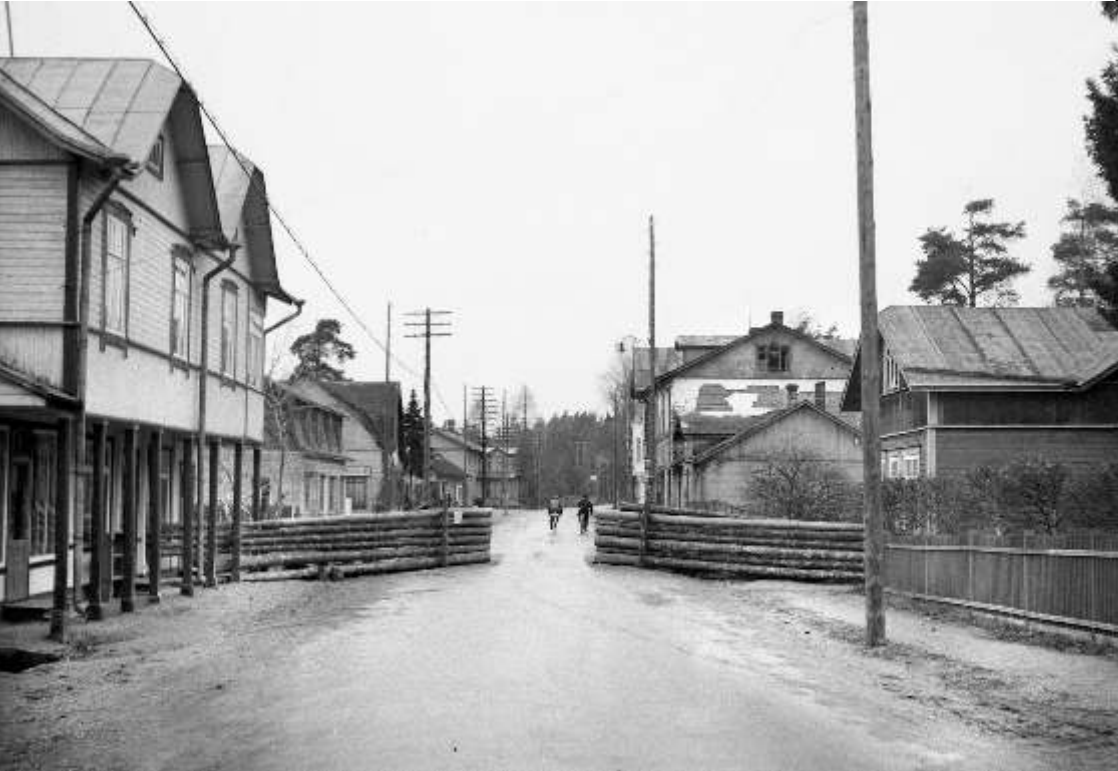
Terijoen keskikylälle rakennettiin katusulkuja YH:n eli yleisten kertausharjoitusten aikana 16.9.–29.11.1939. Kuva: SA-kuva.
