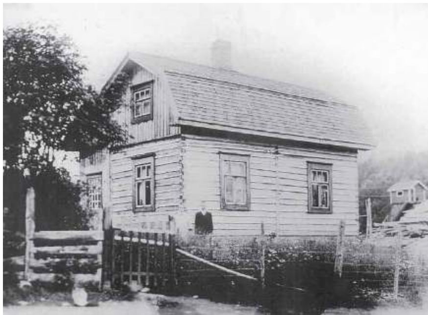
Jonkin aikaa 1920- ja 1930-luvun vaihteessa Verlassa kokeiltiin puiden nostossa myös koneellista nostoa, ”kiramoa”, josta kuvan oikeassa reunassa näkyy osa. Asuinrakennuksen edessä Katajannokassa seisoo tehtaan työläinen Jalmari Aho vaimonsa Idan kanssa. Kuva: Museoviraston kuva-arkisto.
