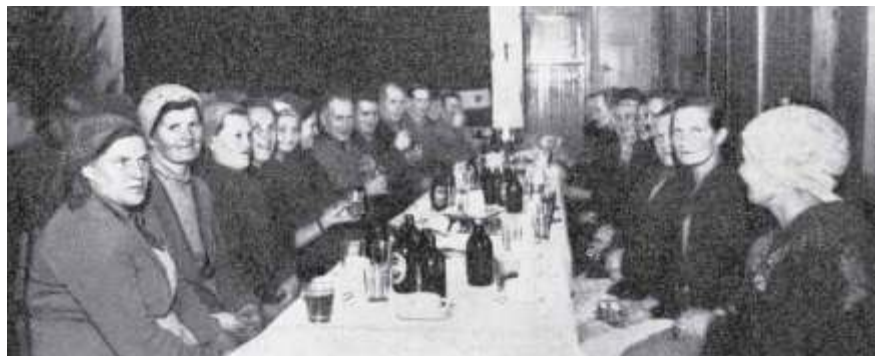
Uuden voimalan harjannostajaisia vietettiin joulukuussa 1953. Työmaalla oli mukana niin miehiä kuin naisia. Kuva: Kymi-yhtymä 1/1954.
