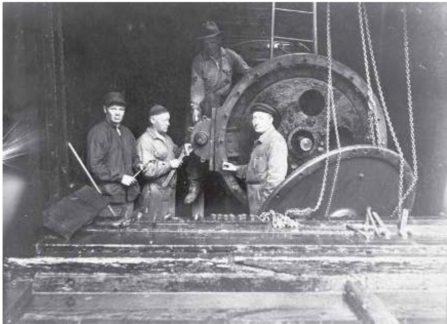
Tehtaalla remonttia tekemässä vas. seppä Theodor Pekkalin (k. 1939), Jalmari Seppälä ja Akseli Forsman. Ylhäällä Antti Niemi. Kuva: Museoviraston kuva-arkisto.
