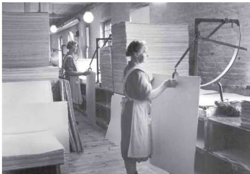
Pahviarkit punnittiin yksitellen ja lajiteltiin painon mukaan vaa'an alla näkyvään lokerikkoon. Huonolaatuiset pahvit palautettiin uudelleenjauhettaviksi. Kuva: Verlan tehtaan arkisto.
