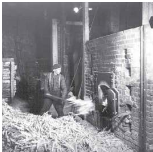
Kuivaamon lämmittämiseen käytettiin polttopuun (vas.) lisäksi mm. kuorimajätteet. Kuva 1960-luvulta, Verlan tehtaan arkisto.
