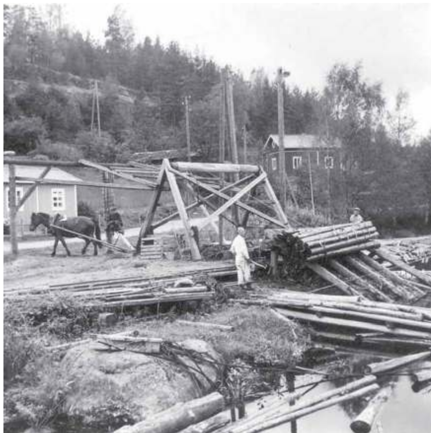
Verlan tehtaalle tulevat puut nostettiin vedestä kosken yläpuolella hevostierron avulla. Alun perin nostoon käytettiin miesvoimin pyöritettävää väkipyörää. Taustalla näkyy tehtaalaisten asuinrakennuksia Katajannokassa. Kuva: Suomen Kuvalehti 1953.
