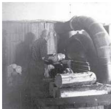
Puut sahattiin ensin pölleiksi ja sitten niistä kuorittiin tumma pintakerros kuorimakoneella. Kuvat 1960-luvulta, Verlan tehtaan arkisto.
