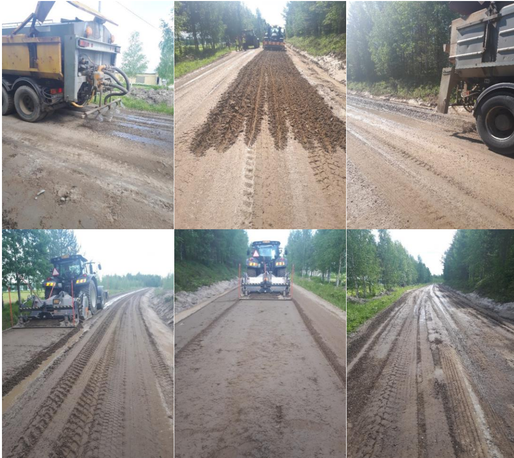
Kuva 2. Työvaiheet vasemmalta ylhäältä, tien pinnan kastelu vedellä, pinnan aukiharaus, modifioitu kuitulietteen levitys, kiviyrsinsekoitus ajokaistoilla ja tien keskellä, sekä pinnan muotoiltu ja tiivistys.
