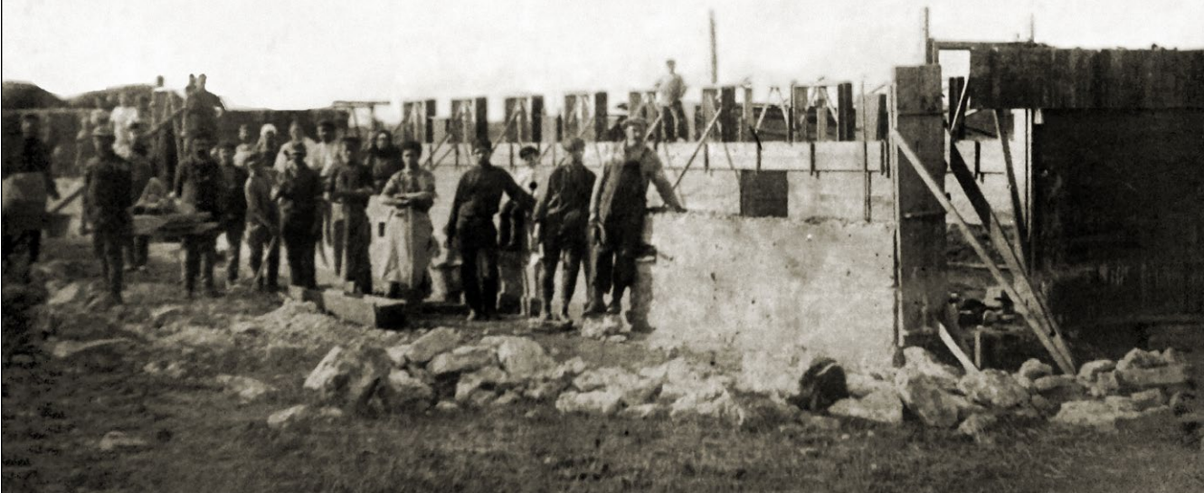
Kylväjän keskusrakennuksen rakentamista. Lähde: Seth Bernstein.
