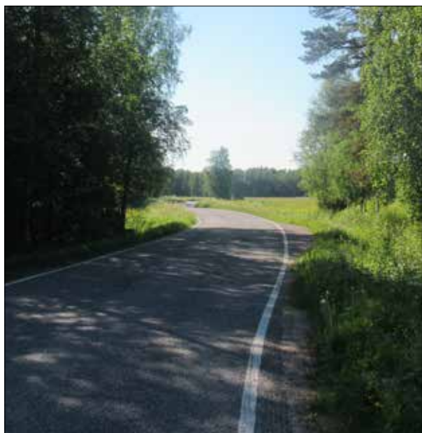
Kuvat 40.–42. Museotien päällyste- ja painumavauriot ovat vähäisiä. Tien varressa on väistöpaikkoja, joista osa on merkitty liikennemerkillä. Kuvat: Laura Soosalu.
