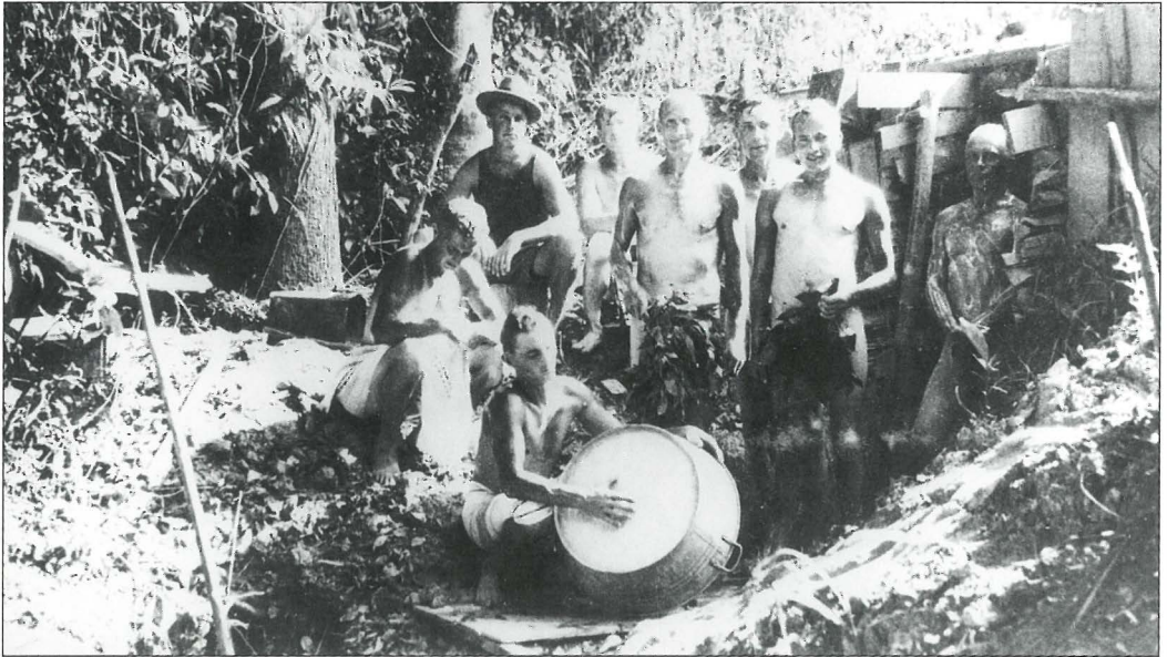
Suomalaisia saunoja tietyömaalla Daintreessä Queenslandissa vuoden 1930 alkupuolella. – Siirtolaisuusinstituutti .
