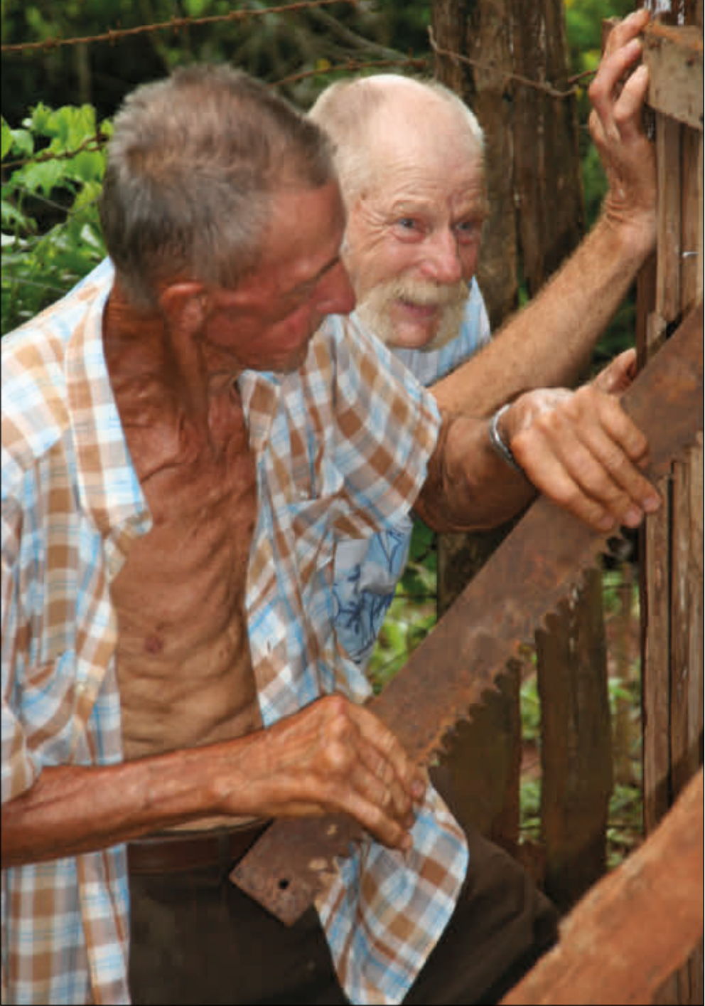
likka ja Manu korjaava Manun saunan ovea.
