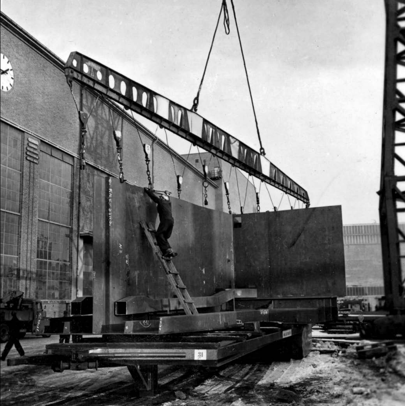
En sektion håller på att flyttas utanför svetshallen. Bild: Göteborgs stadsmuseum
