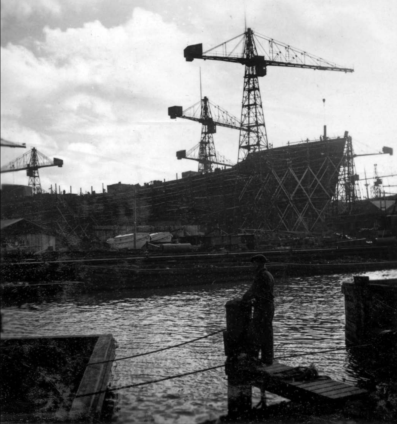
En vy över Götaälven på ett fartyg under byggnation. Artur Nilssons samlingar/ Regionarkivet
