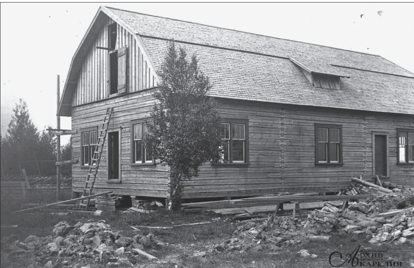
Ruokala-, keittiö- ja leipomorakennus rakennusvaiheessa (Karjalan tasavallan kansallisen arkiston kokoelmat).
