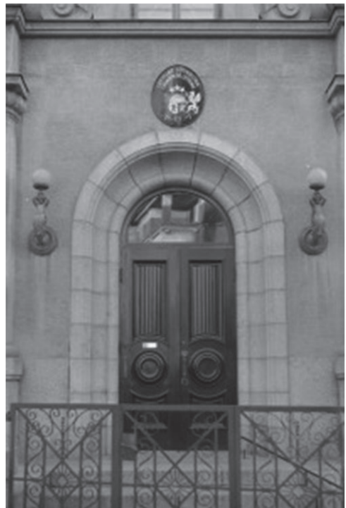
Kuva 23. Latvian Suurlähetystön sisäänkäynti. Lähetystö on arkkitehti Valter Jungin suunnitelma ja rakennettu 1921. Kuva: Pietinen 1934, Finna.
