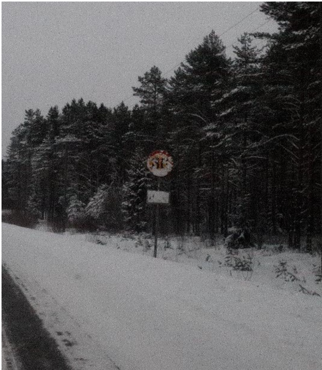
Kuva 4. Puhdistustarpeellinen liikennemerkki (RoadData)
