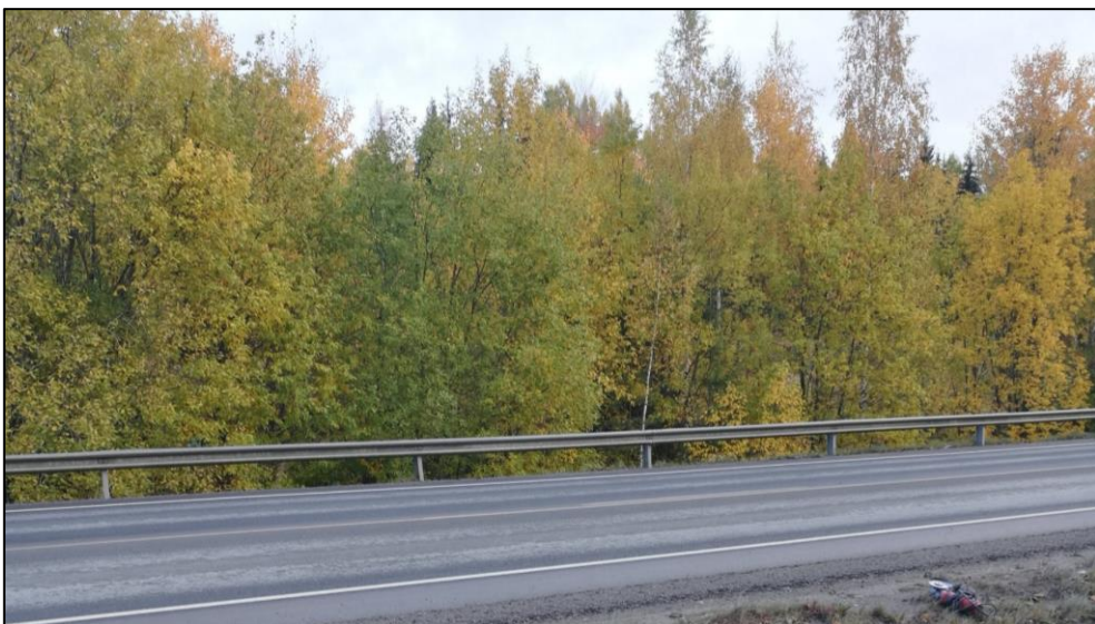
Kuva 2.4 Yleiskuva Lempäälän testikohteelta. Keskimääräinen vuorokausiliikenne (KVL) vuonna 2018 kohteella oli 6540 ajon. /vrk.
