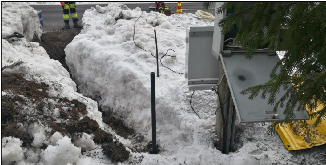
Kuva 3.3 Asennusolosuhteet Saaramaan koekohteella. Tien penkereellä oli lunta enimmillään 1,5 m paksuinen kerros.
