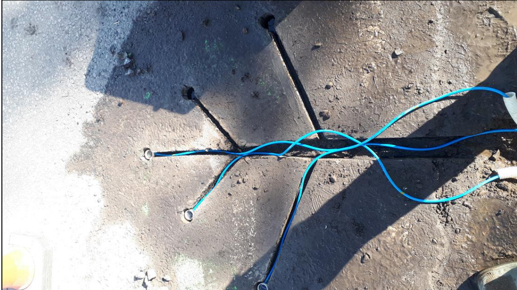
Kuva 3.4 Kontaktimikrofonien asennusta puuta muistuttavaan muotoon Alavuden kohteella. Uloimmat mikrofonit ovat tien reunaviivan tuntumassa, latvassa oleva mikrofoni on lähellä ajouraa. Osa mikrofoneista suojattiin muovikoteloilla, osa jätettiin suojaamatta.
