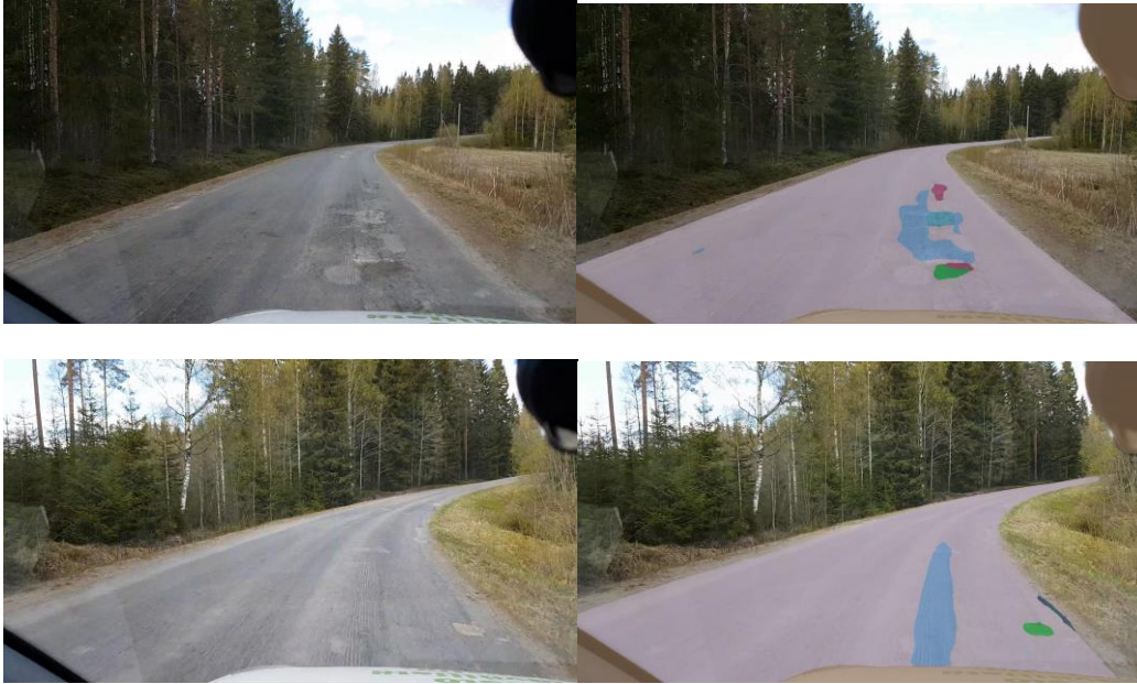
Kuva 14. Konenäkö: kohtalainen reikä. Henkilö 1: ei reikä tunnista (2 esimerkkiä, segmentointikuvassa vihreä väri).
