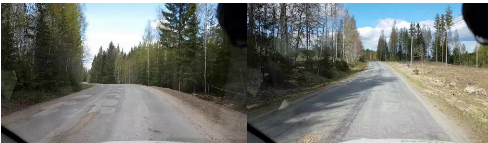
Kuva 12. Henkilö 1: vakava reikä. Konenäkö ei reikä-tunnistusta (2 esimerkkiä).
