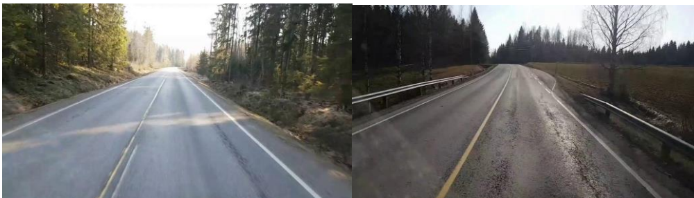
Kuva 13. Henkilö 1: vakava halkeama. Konenäkö: ei halkeamatunnistusta (2 esimerkkiä).
