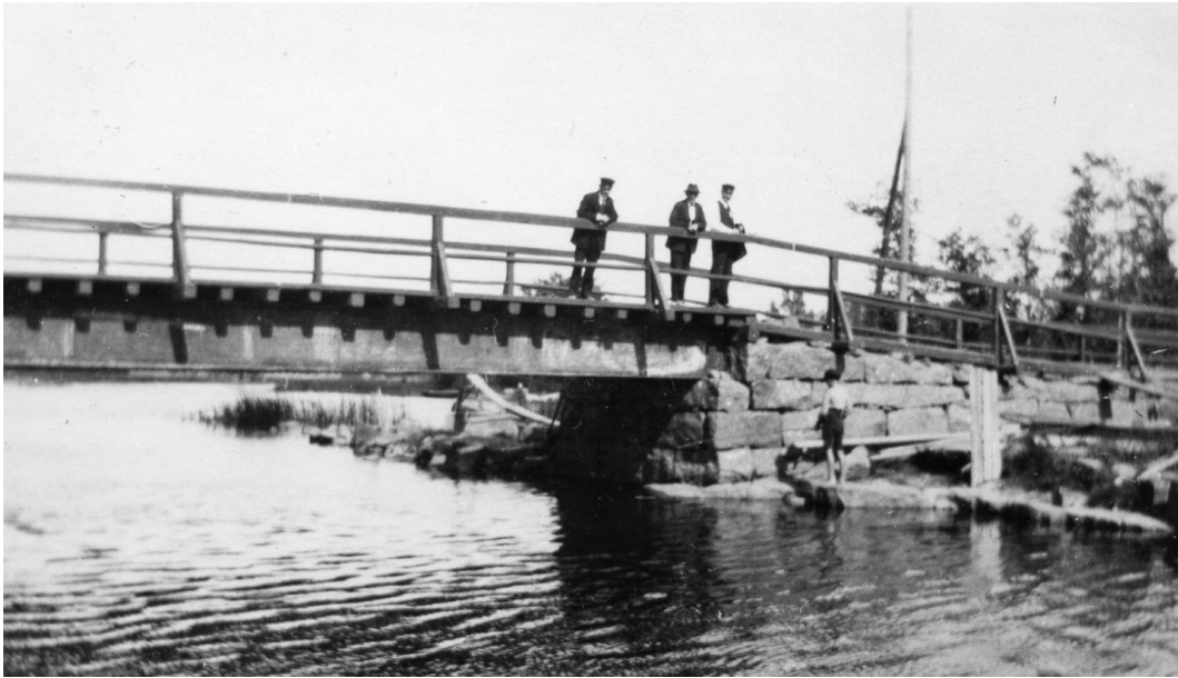
Kuva 5. Nykyistä siltaa edeltävä Mullinkosken silta oli rakennettu v. 1923. Kuva Väylävirasto, Mobilia.
