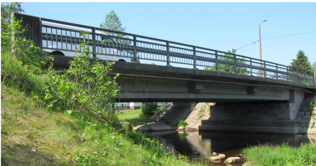
Kuva 29. Sillan korjaustyö. Poikkittaisjännityksen betoniulokkeet. Kuva 2018. Valokuva Laura Soosalu.
