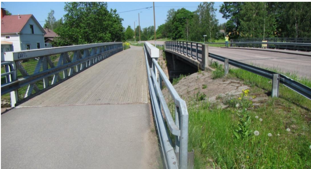
Kuva 4. Museosillan länsipuolelle on myöhemmin rakennettu erillinen kevyen liikenteen silta. Kevyen liikenteen silta on teräsinen ristikkosilta, jossa on puukansi. Muutoin sillan ympäristö on säilynyt melko lailla museointiajankohdan mukaisena. Kuva Laura Soosalu.
