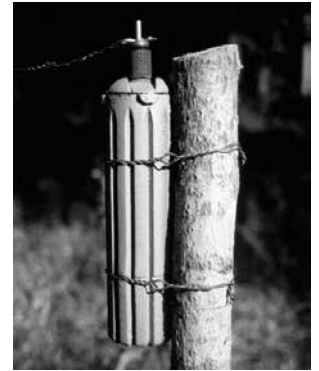
■ Putkimiina 43 86 vaajaan asennettuna. Kuva: Sotamuseo.
