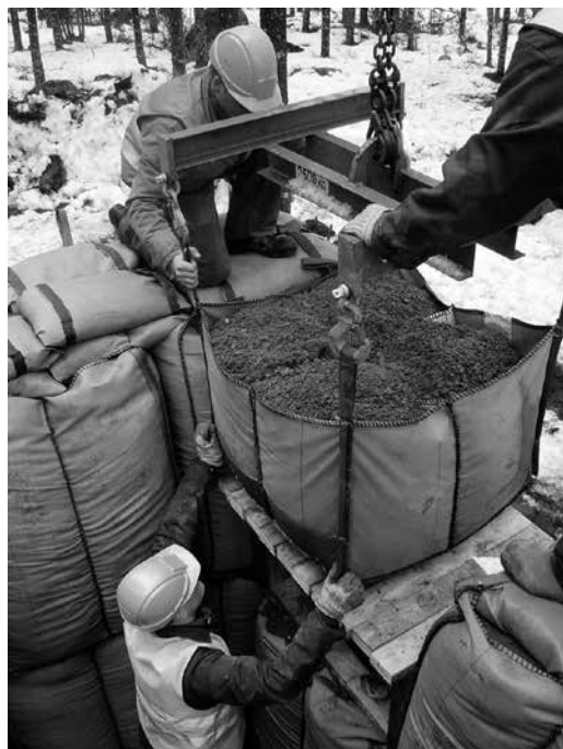
■ Suurhiekkasäkkien käyttö on yksi keino lisätä kriittisten kohteiden suojaa maanpäällisellä linnoittamisella. Kuva: Mikko Sivonen.
