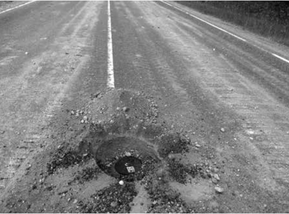
■ Moniherätepanssariimiina 12 pystyjyrsimen tekemässä miinasijassa ennen naamiokerroksen levittämistä. Kuva: Pekko Sipari.
