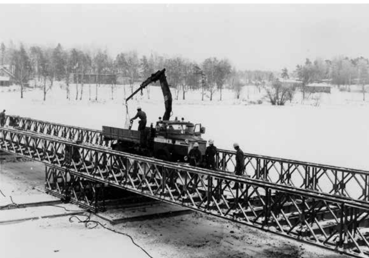
■ Inkeröisiin rakennettua Bailey-siltaa puretaan. Myös tämä silta lepäsi Uniflote-ponttoneista rakennettujen kelluvien välitukien päällä. Kuva: Museo Militaria.
