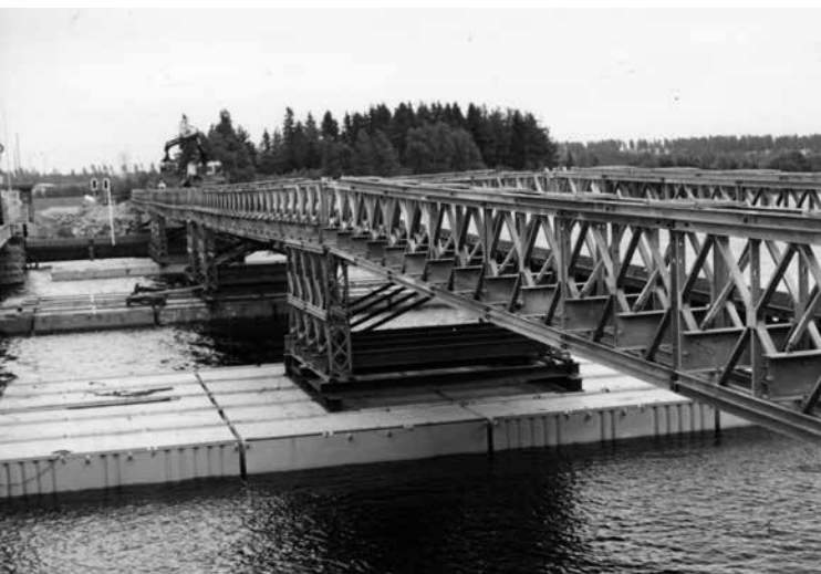
■ Uniflote-ponttonien varaan rakennettujen uivien välitukien päälle rakennettu Bailey-silta. Kuva: Sotamuseo.
