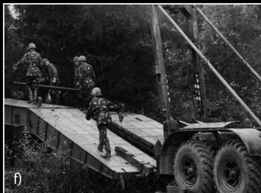
■ Panssariprikaatille hankittujen TMM-3- ja TMM-3M -silta-autojen kuoppasiltakalustoja voitiin laskea peräkkäin ja yhdistää toisiinsa, jolloin saatiin aikaan leveämmän esteen ylittämisen mahdollistava silta. Kuvat: a-c Sotamuseo ja kuvat d-e Museo Militaria.
