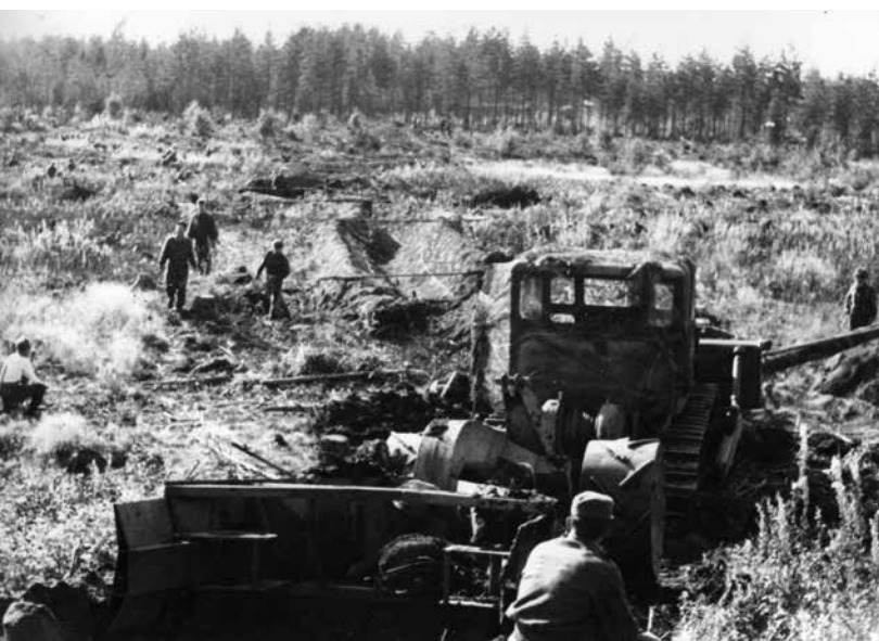
■ Linnoittamisen nopeuttamista kokeiltiin erilaisten kaivinkone- mallien lisäksi myös Allis HD-16 oja-auralla. Vuoden 1960 pioneerileirillä todettiin menetelmän sopivan huonosti yhdysmaahan kaivamiseen kivikkoiseen sekä mäki- seen maastoon. Syntynyt kaivanto oli lisäksi vaikea maastouttaa. Kuva: Sotamuseo.
