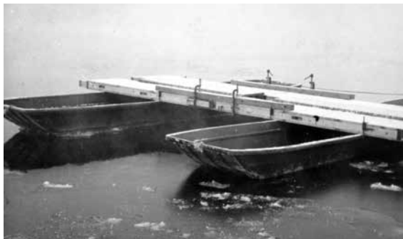
■ Kahden ruuhan siltajakso Ruuhikalusto 2:a kokeiluissa Koriolla marraskuussa 1955. Kalusto otettiin käyttöön seuraavana vuonna ruuhikalusto m/56:na. Kuva: Sotamuseo.
