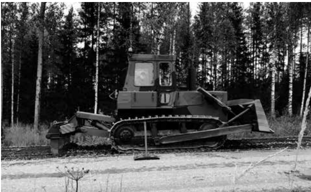
■ Panssaroitu telatraktori repii kestopäällystettä. Kuva: KARPR/KYMPIONP.
