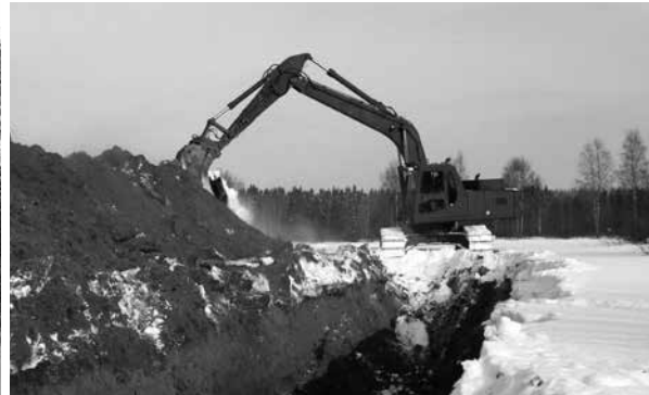
■ Panssaroitu telakaivinkone kaivamassa tiekatkosta. Kuva: Veli-Pekka Tikkanen.
