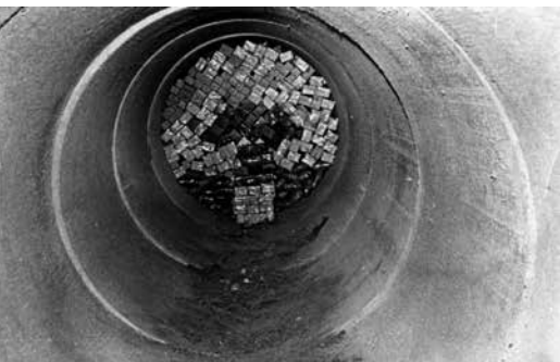
■ Kenttäkoe Pahkajärven kokeilutiellä 1970-luvun alusta. Tierumpu on panostettu.... Kuva: Museo Militaria.
