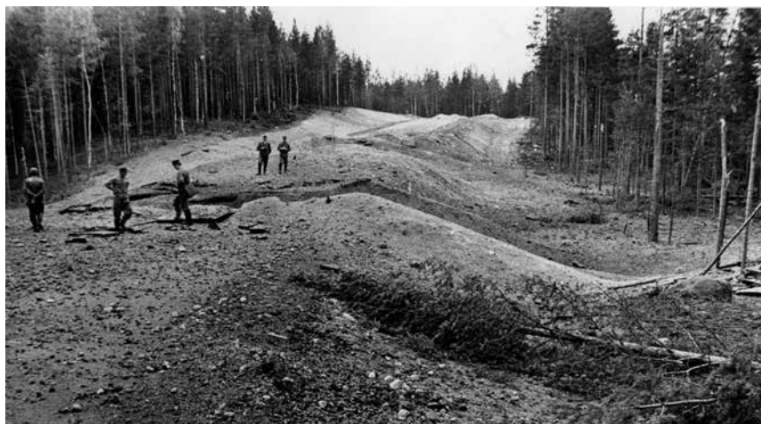
■ ...ja räjäytyksen jälkeen on syntynyt panssariajoneuvojen ylittämisen estävä tiekatkos. Kuva: Museo Militaria.
