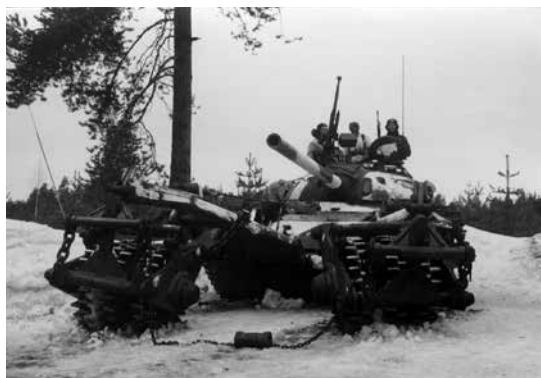
■ Taistelupanssarivaunuun T-54 asennettu KMT-5M -miinanraivausjyrä. Kuva: Museo Militaria.
