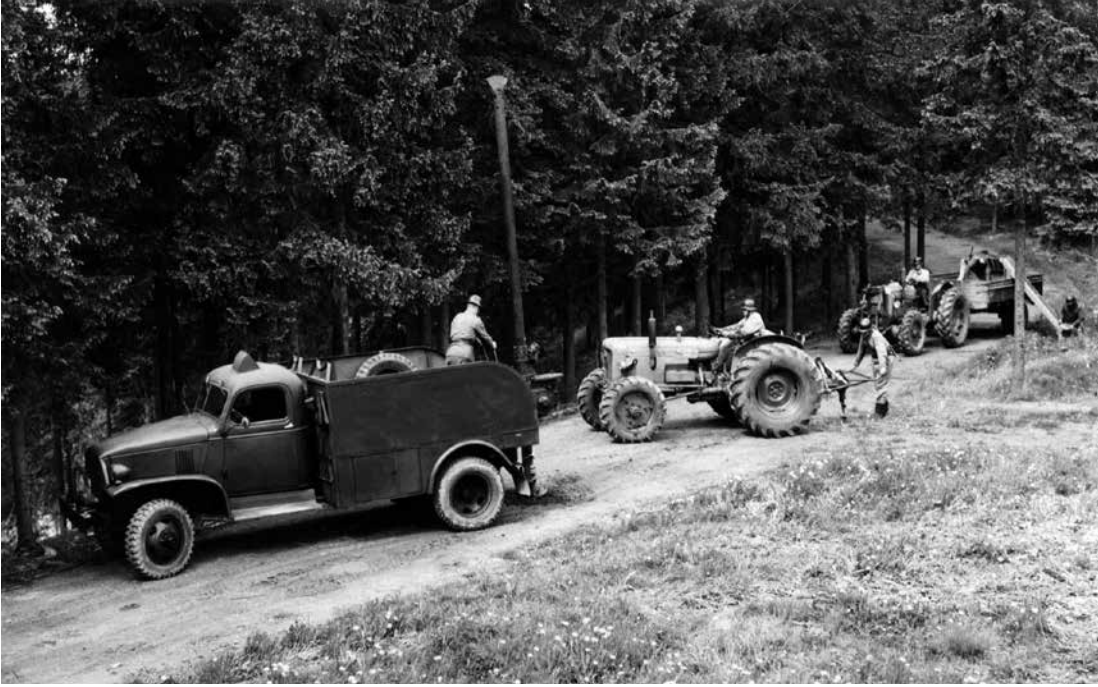
■ Maapora-autolla varustetun pioneerijoukkueen suluttamisnopeus nelinkertaistui. Tässä 1960-luvulla otetussa kuvassa käytetään myös traktoriin asennettua maakairaa ja miinojen levittämistä nopeuttavaa miinaluiskaa. Kuva: Museo Militaria.
