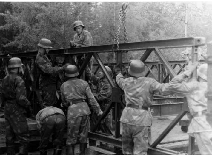
■ Bailey-palkkisiltakaluston kehää nostetaan edelliseen kehäjaksoon kiinnitettäväksi. Kuva: Museo Militaria.
