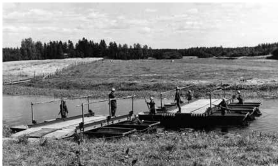
■ Ruuhisiltaa kootaan ruuhikalusto m/56:sta. Kuva: Sotamuseo.
