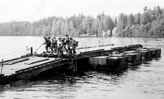
■ Ponttonikalusto m/63:sta rakennettua siltajaksoa irrotetaan rantalaiturista. Kuva: Museo Militaria.
