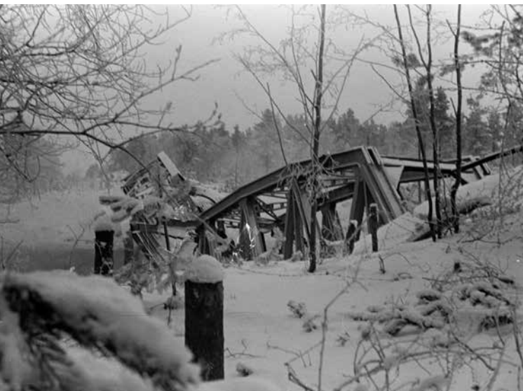
■ Siltojen ”joukkotuhon” jälkiä Kannaksella. Sakkolan Kiviniemen rautatiesilta hävitettiin räjäyttämällä 3. joulukuuta 1939. Kuva: SA-kuva.
