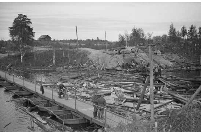
■ Vihollisen räjäyttämän sillan viereen Vuohjärvellä 29.9.1941 rakennettu kevyt ruuhisilta. Kuva: SA-kuva.
