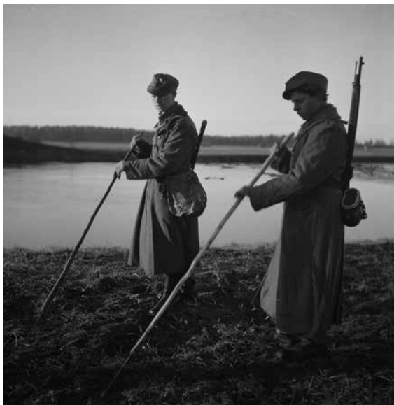
■ Saksalaisten asentamia miinoja paikannetaan piikitutkaimilla Tervolassa 10.10.1944. Kuva: SA-kuva.
