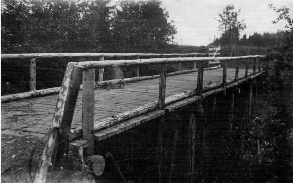
■ Joskus sotaharjoituksissa päästiin tekemään oikeitakin töitä. Reserviläiskompanian 6.7.1932 rakentama rivistösilta. Kuva: Museo Militaria.
