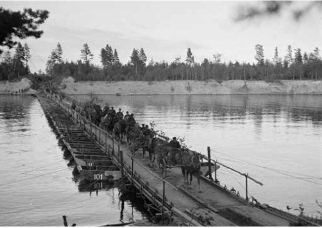
■ Äyräpään ponttonisilta 24.8.1941. Kuva: SA-kuva.
