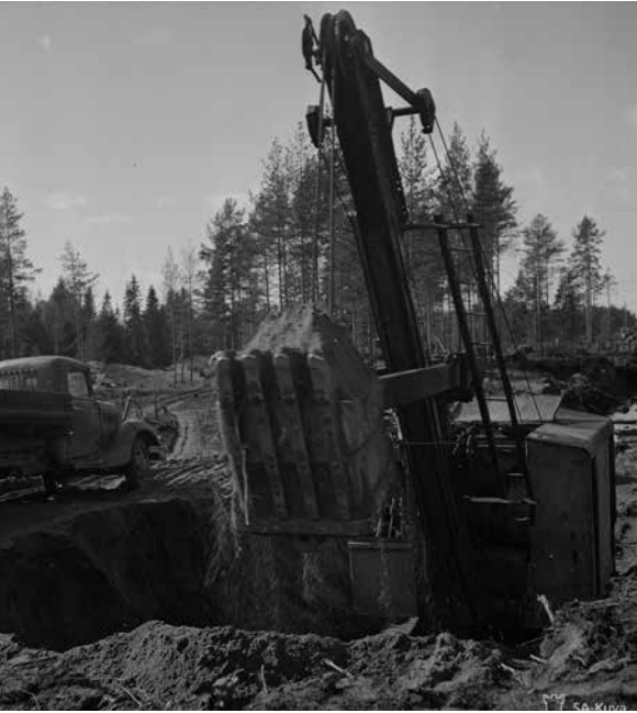
■ Kaivukone työssään Uuksussa Laatokan koillispuolella syyskuussa 1942. Kuva: SA-kuva.
