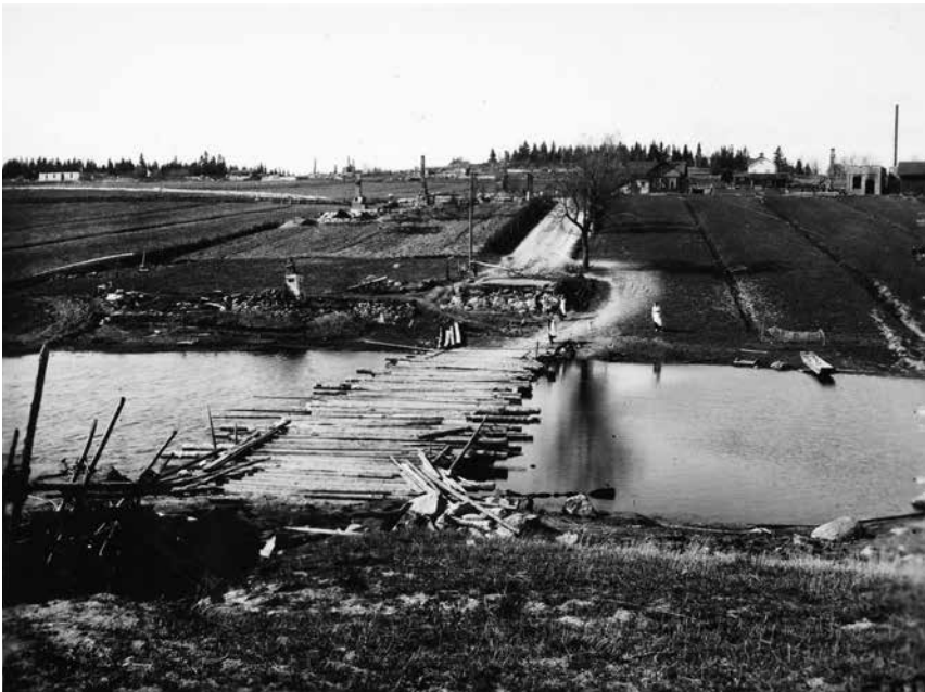
■ Punaisten polttaman maantiesillan tilalle valkoisten rakentama tukkilauttasilta Vesilahdella Narvan kylässä. Kuva: Museovirasto.
