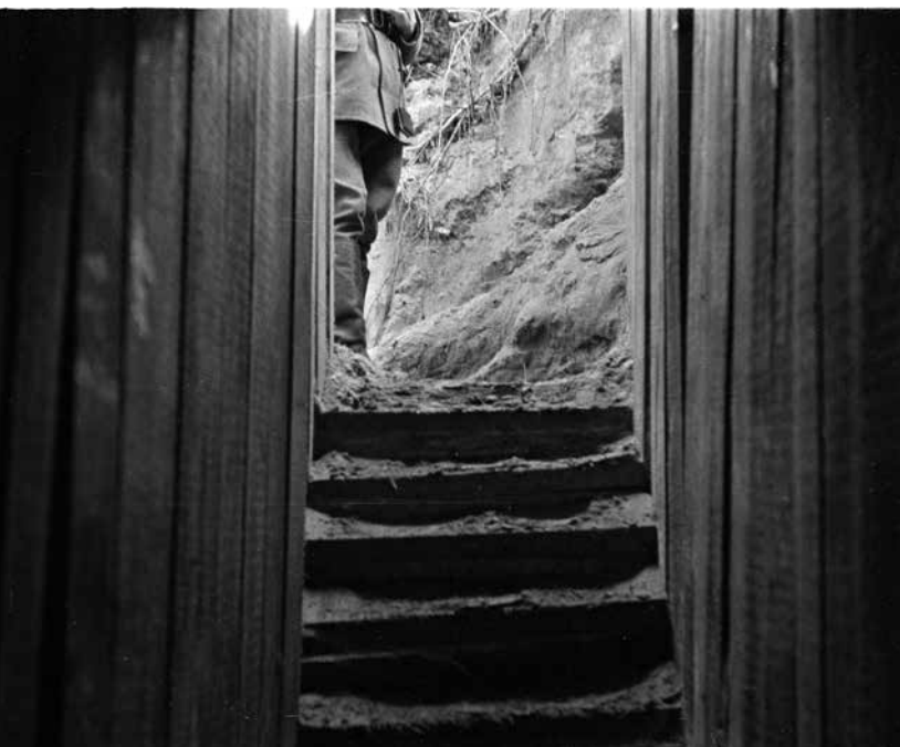
■ Hangon rintamalla vihollisen asemien alle kaivettu tunneli 29.8.1941. Kuva: SA-kuva.
