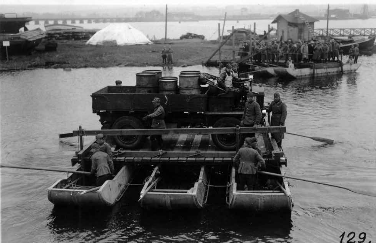
■ Ponttonikokeiluja m/25:llä vuonna 1932, vuorossa kalustonkuljetus ponttonilautalla. Kuva: Museo Militaria.
