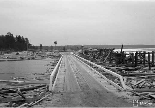
■ Räjätetyn sillan viereen rakennettu uusi silta Porajärven–Seesjärven tiellä 19.10.1941. Kuva: SA-kuva.
