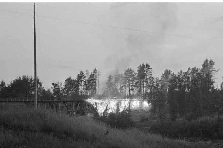
■ Uuksunjoen rautatie-silta palaa 5.7.1944.
