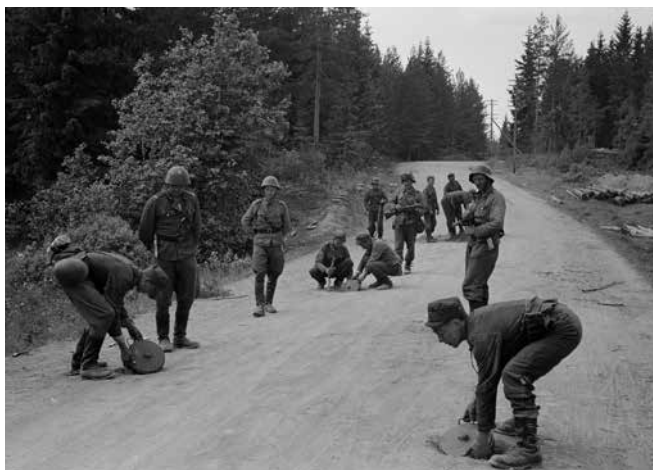
■ Panssarmiinoitusta panssarmiina m/41:stä rakennetaan Ihantalassa 30.6.1944. Kuva: SA-kuva.
