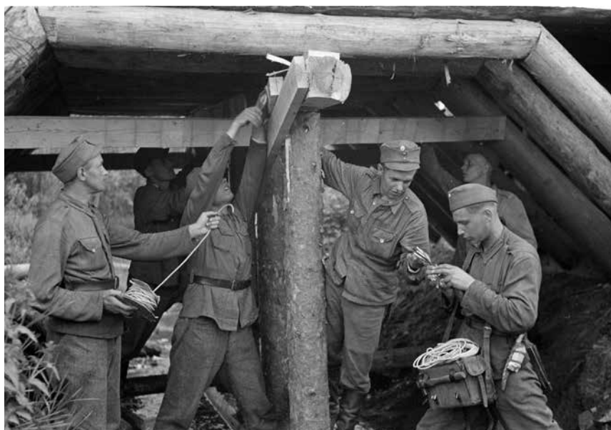
■ Pienempää kenttäsiltaa panostetaan 2.7.1944. Kuva: SA-kuva.
