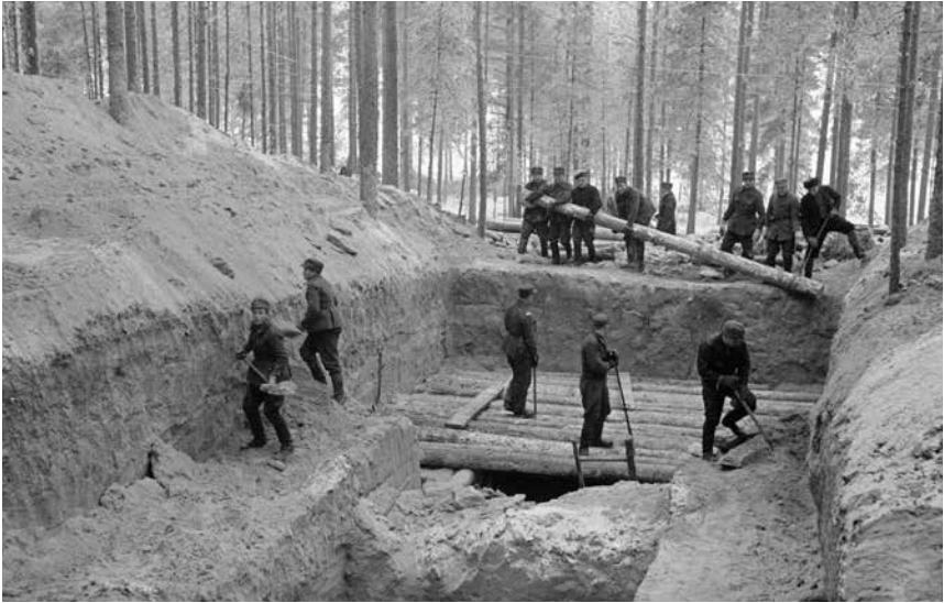
■ Pioneeriyksiköitä tuli käyttää vain teknillisesti vaativimpien linnoitteiden rakentamiseen. Korsun tekoa Sakkolan koillispuolella Pyhäjärvellä 17.12.1939. Kuva: SA-kuva.
