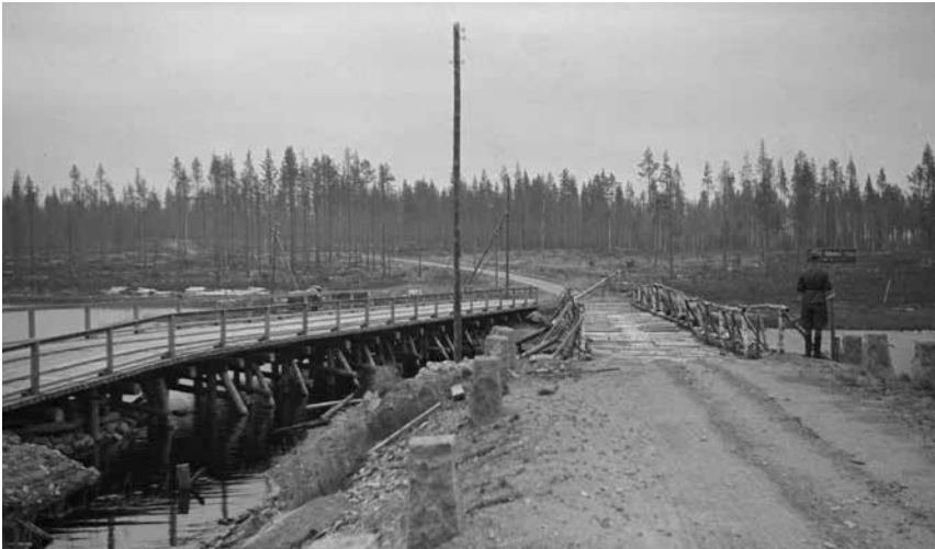
■ Jääkäripataljoona 6:n taistelupaikka Tolvajärven–Aittojoen tiellä Ristisalmella 28.9.1943 kuvattuna. Oikealla saksalaisten heti taistelun jälkeen 6.8.1941 rakentama pioneerisilta ja vasemmalla saksalaisten myöhemmin rakentama Leutnant Mühlen-back-Brücke taistelussa kaatuneen luutnantin muistoksi. Kuva: SA-kuva.
