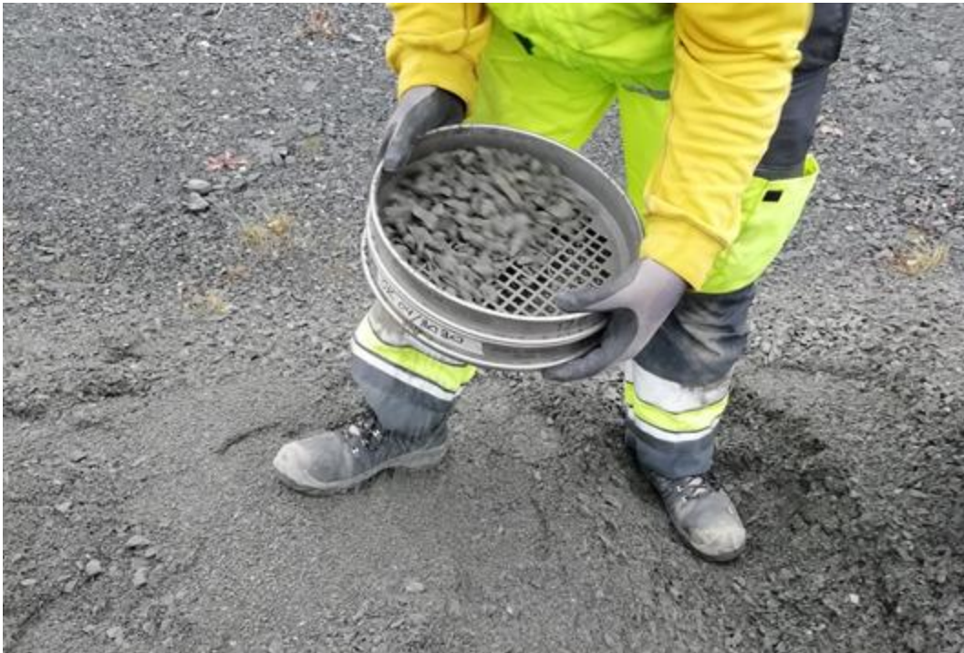
Kuva 30. Kiviaineksen seulontaa B louhoksella (Niko Hietala 2018).
