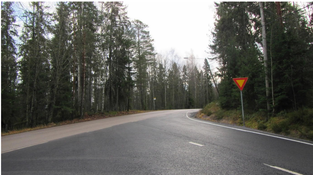
Kuva 17. Lepsämänjoentien liittymän huono liittymisnäkemä Lahnuksentielle Espoon suuntaan (kuva: Kati Palo-Junttila).
