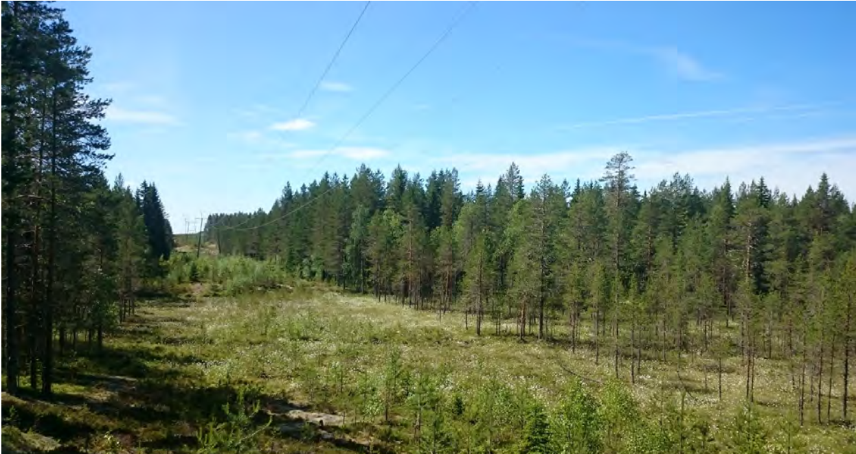
Kuva 6. Sähkölinja kulkee Ristiharjun läpi.
