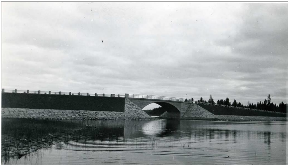
Kuva 11. Tervasalmen silta kuvattuna arviolta valmistumisen jälkeen ajanjaksolla 1934–35. Valokuvassa erottuvat komeat hakkukivikeilat. Myös penkereen alaosa on kivetty, mutta nykyisin sitä peittää kasvillisuus. Liikennevirasto-Mobilia kokoelmat.
