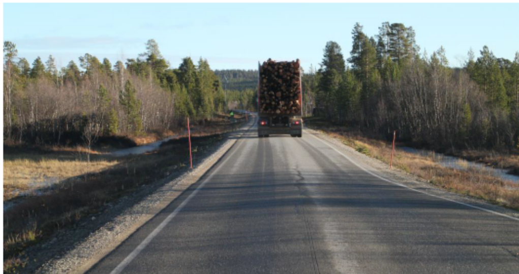
Kuva 10 Näkymä Angelintien Percoaseman sijaintipaikalle Inarin suuntaan 16.10.2015. Percoasema on kuvassa tien vasemmalla puolella rekan etupuolessa.
