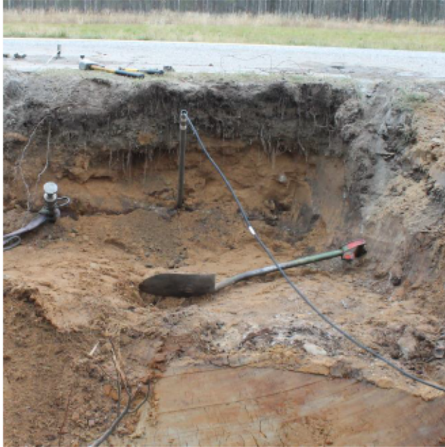
Kuva 2. Huokosvedenpaineanturin asennusta tierakenteen alla olevaan pohjamaahan Simossa.
