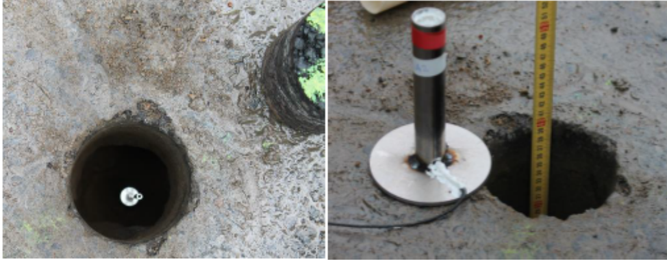
Kuva 3. Siirtymäanturin asentamista Kyyjärvellä.
