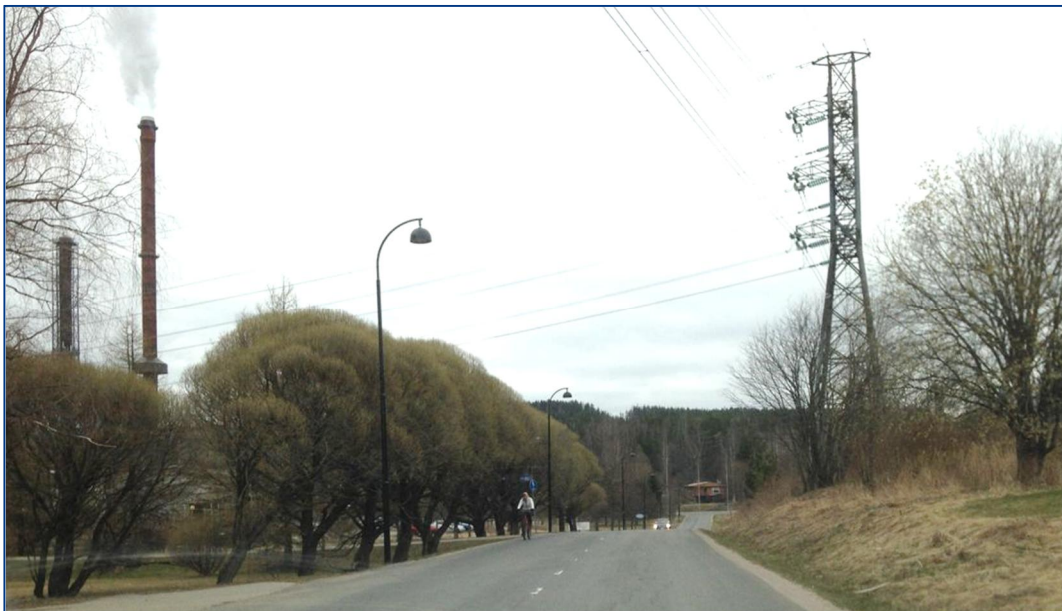
Kuva 28. Osa Kammintien varressa sijaitsevista puista joudutaan kaatamaan jalankulku- ja pyörätien rakentamisen takia.
