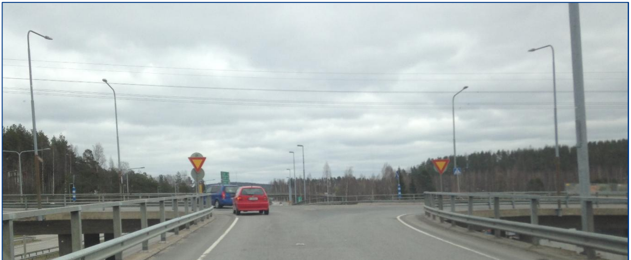
Kuva 17. Ramppi liittymässä on huonot näkemät, ja siinä onkin tapahtunut useita liikenneonnettomuuksia.
