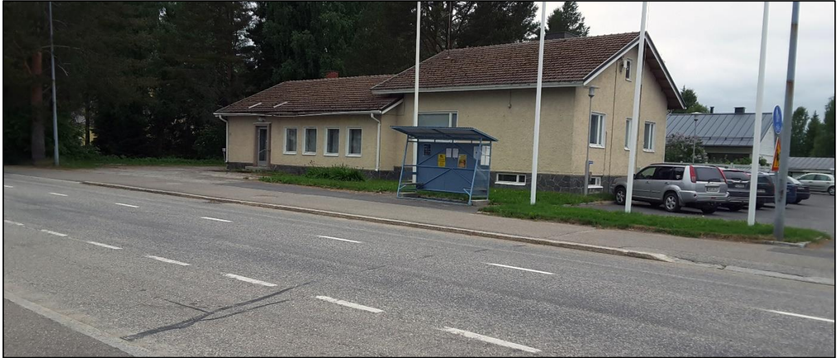
Kuva 12. Ristijärvi L -pysäkillä on pysäkkikatos, mutta ei pysäkkimerkkiä eikä levikettä.
