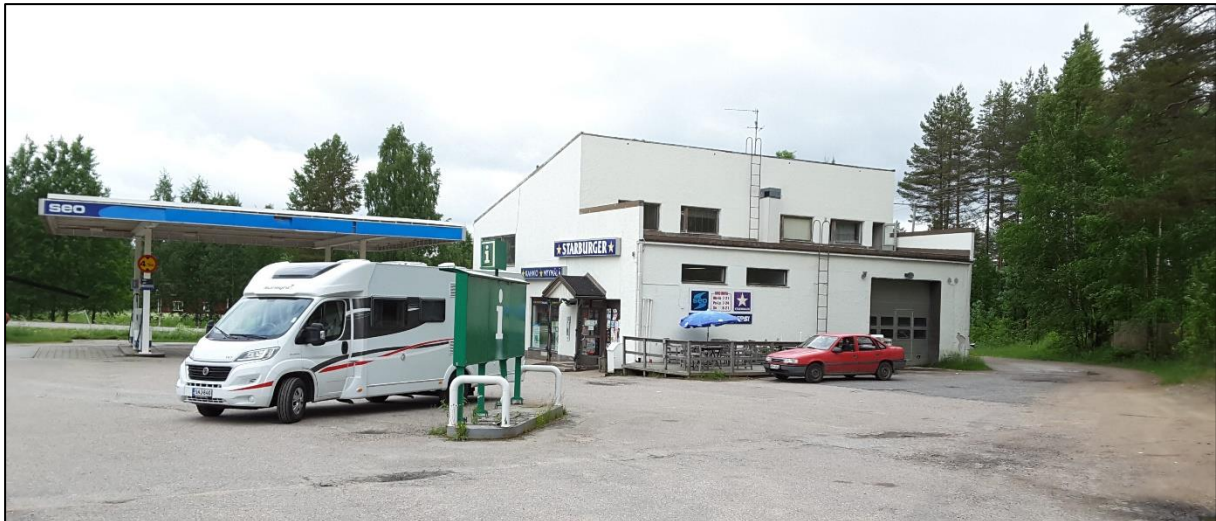
Kuva 3. Hyrynsalmi SEO sijaitsee SEO-huoltoaseman pihaassa. Pysäkkiä ei ole merkitty piha-alueelle mitenkään, mutta sisällä on tarjolla aikataulutietoja.
